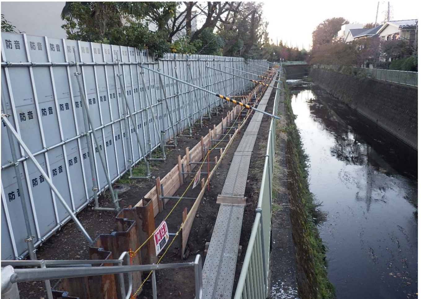
右岸上流側：布掘り完了
