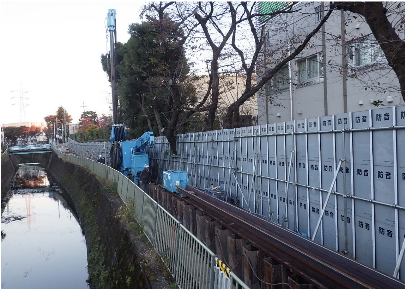
右岸下流側：鋼矢板圧入（GRB工法）
