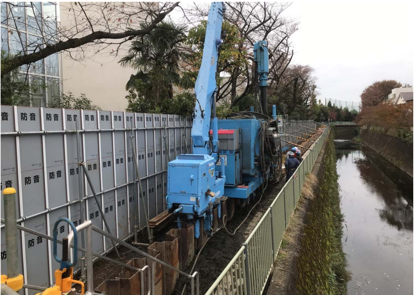
右岸上流側：鋼矢板圧入工（GRB工法）
