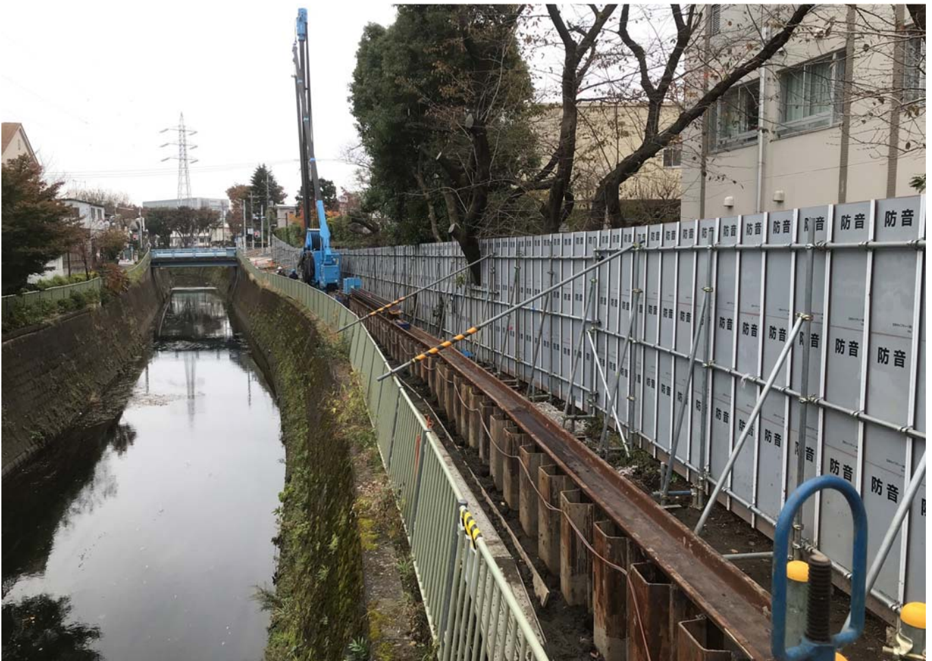
右岸下流側：鋼矢板圧入工（GRB工法）
