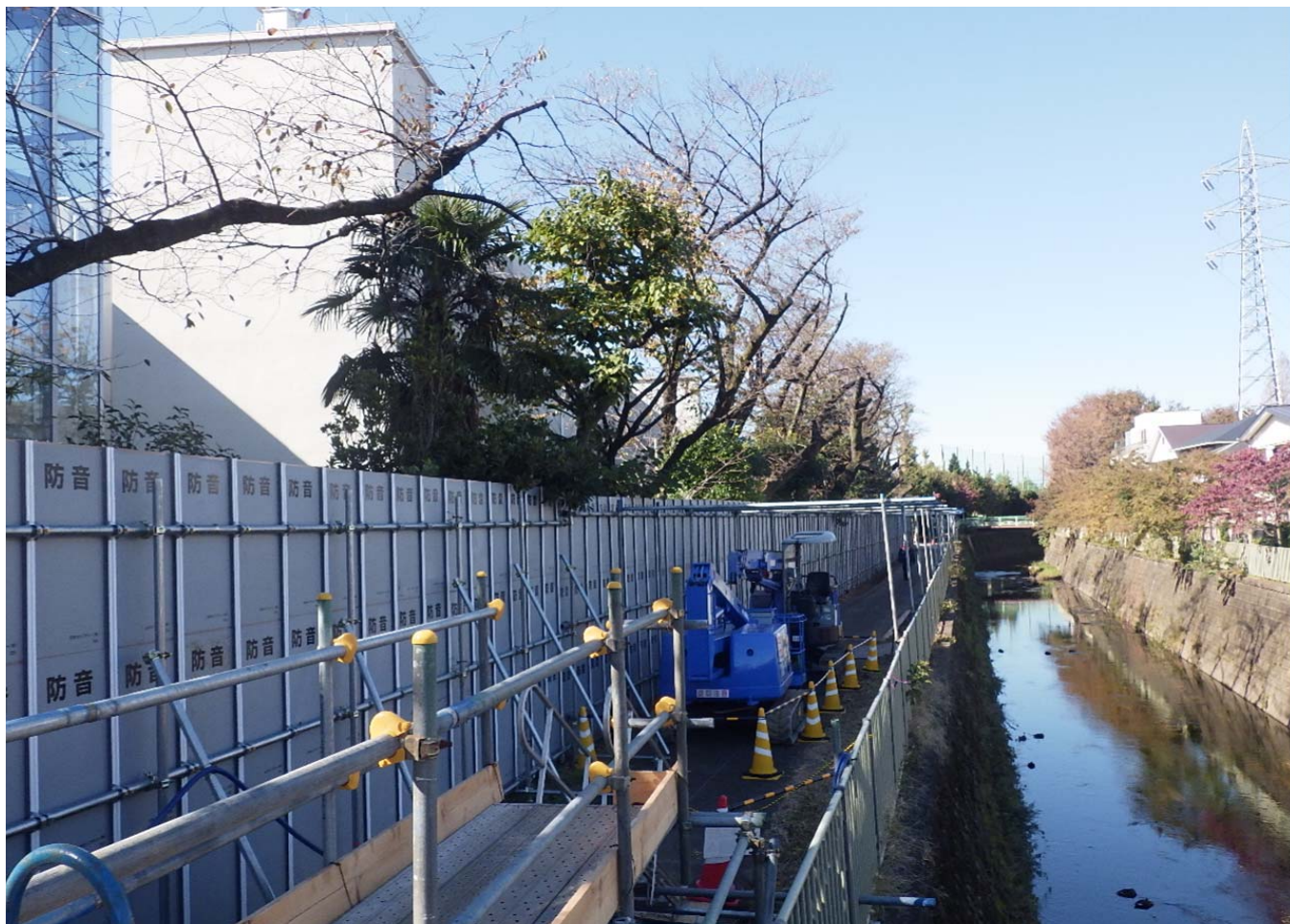
右岸上流側：樹木剪定完了
