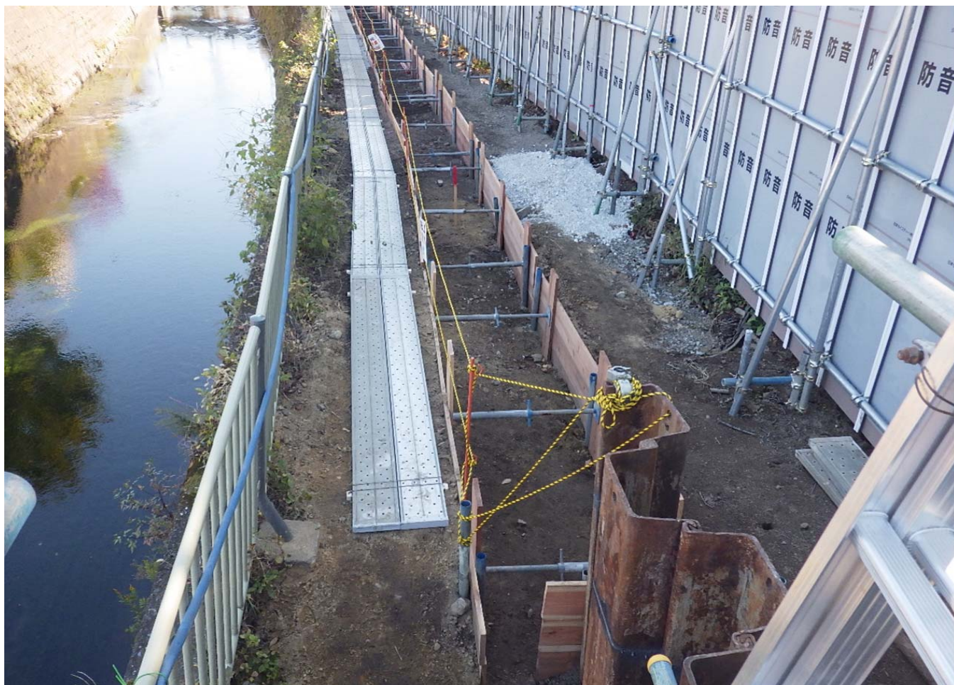
右岸下流側：鋼矢板工 布掘り状況
