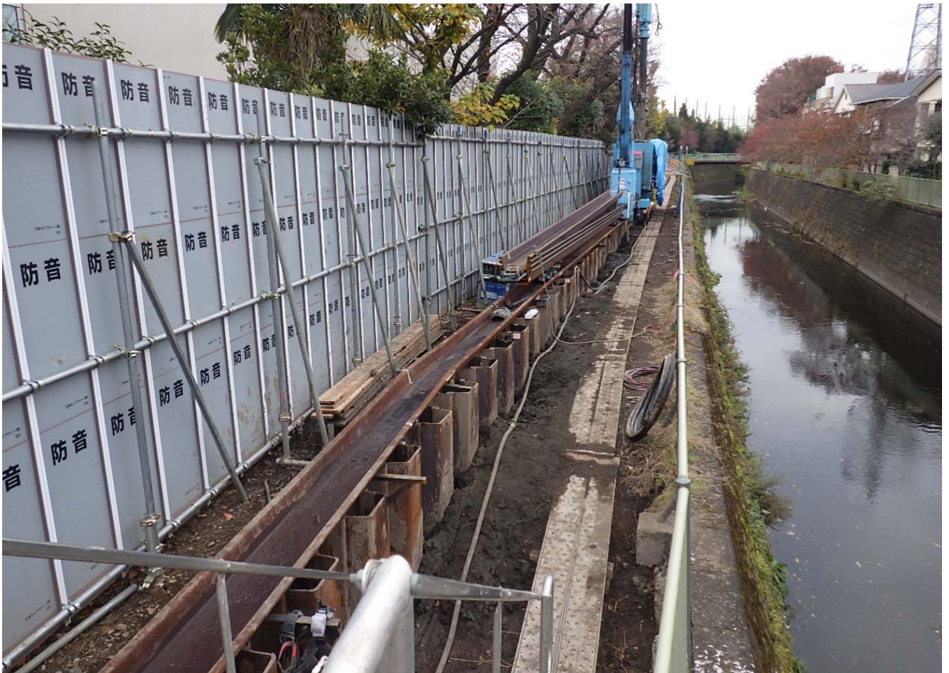
右岸上流側：鋼矢板圧入工（GRB工法）
