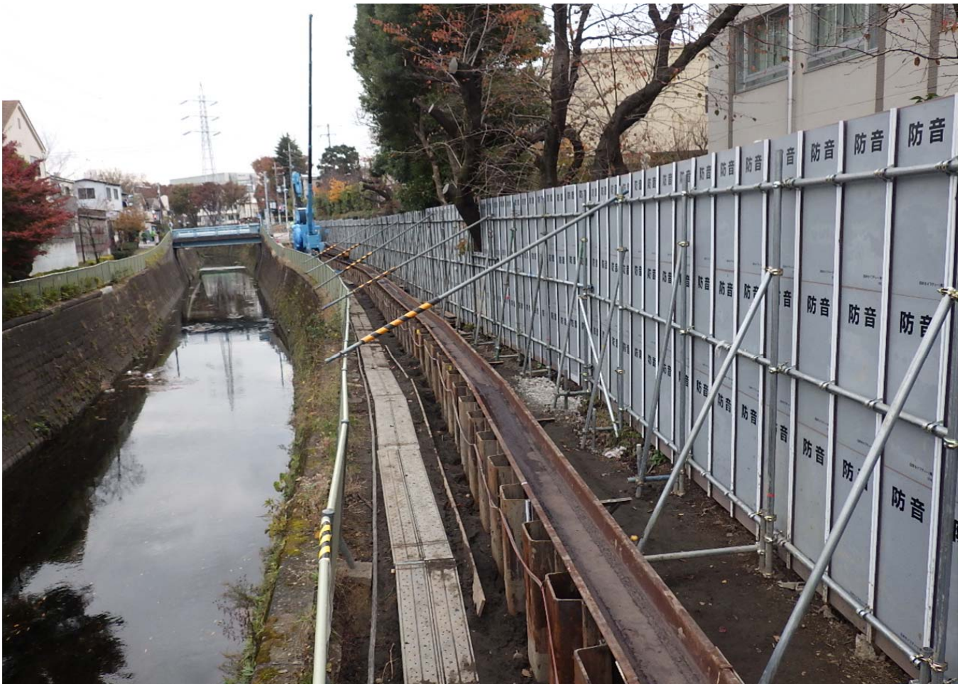
右岸下流側：鋼矢板圧入工（GRB工法）
