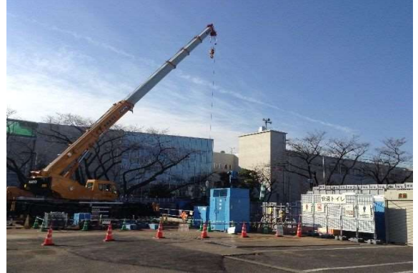
施工用栈橋での作業
