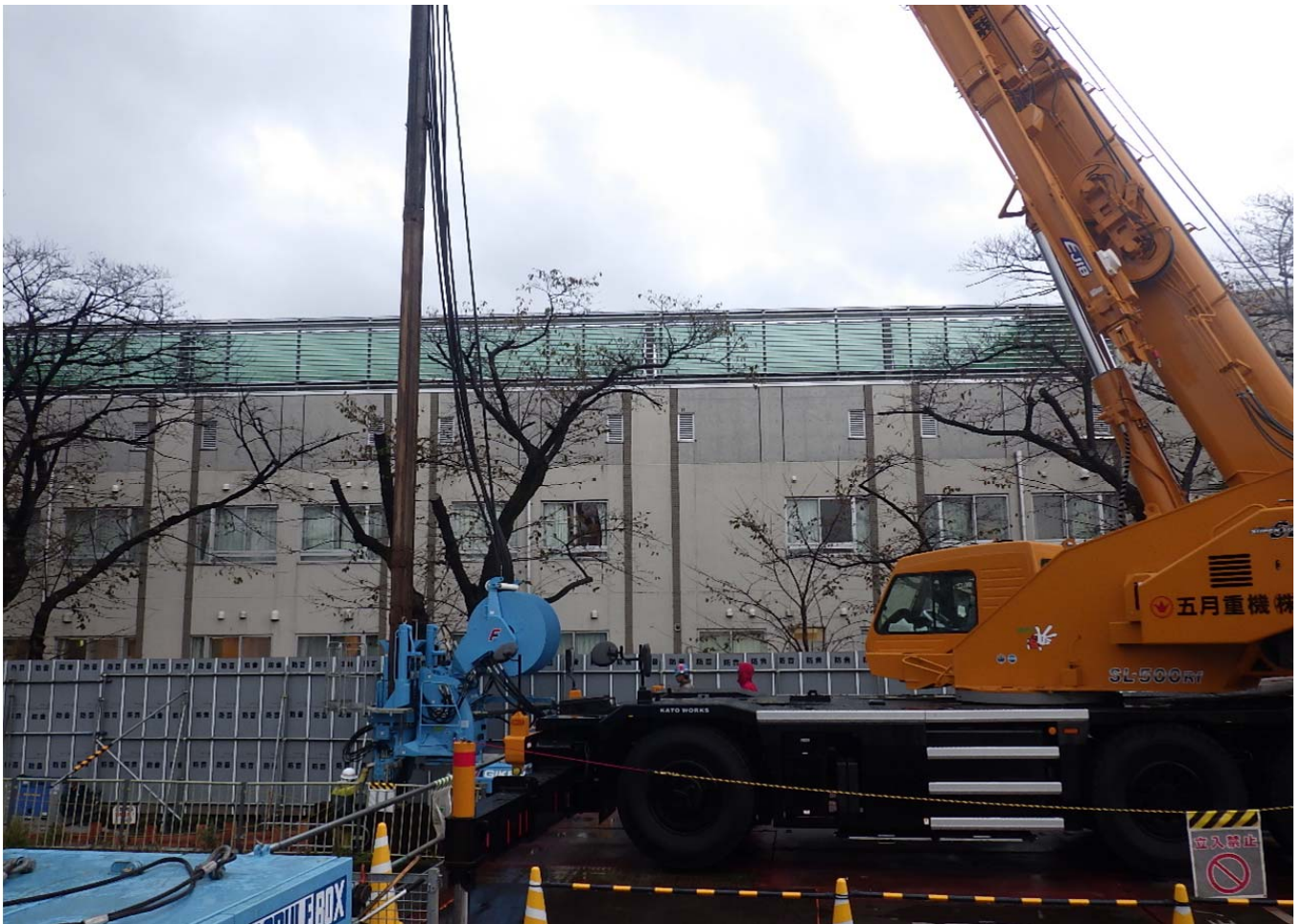
右岸下流側：土留め（鋼矢板）打設状況
