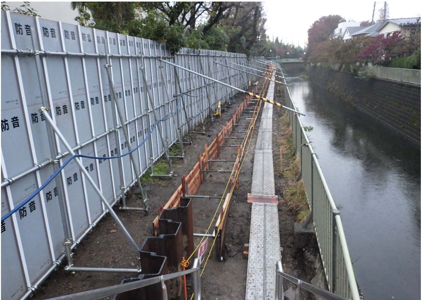
右岸上流側：布掘り設置
