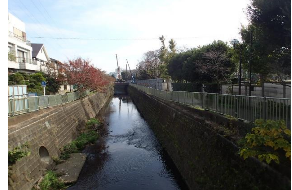
施工用栈橋での作業
