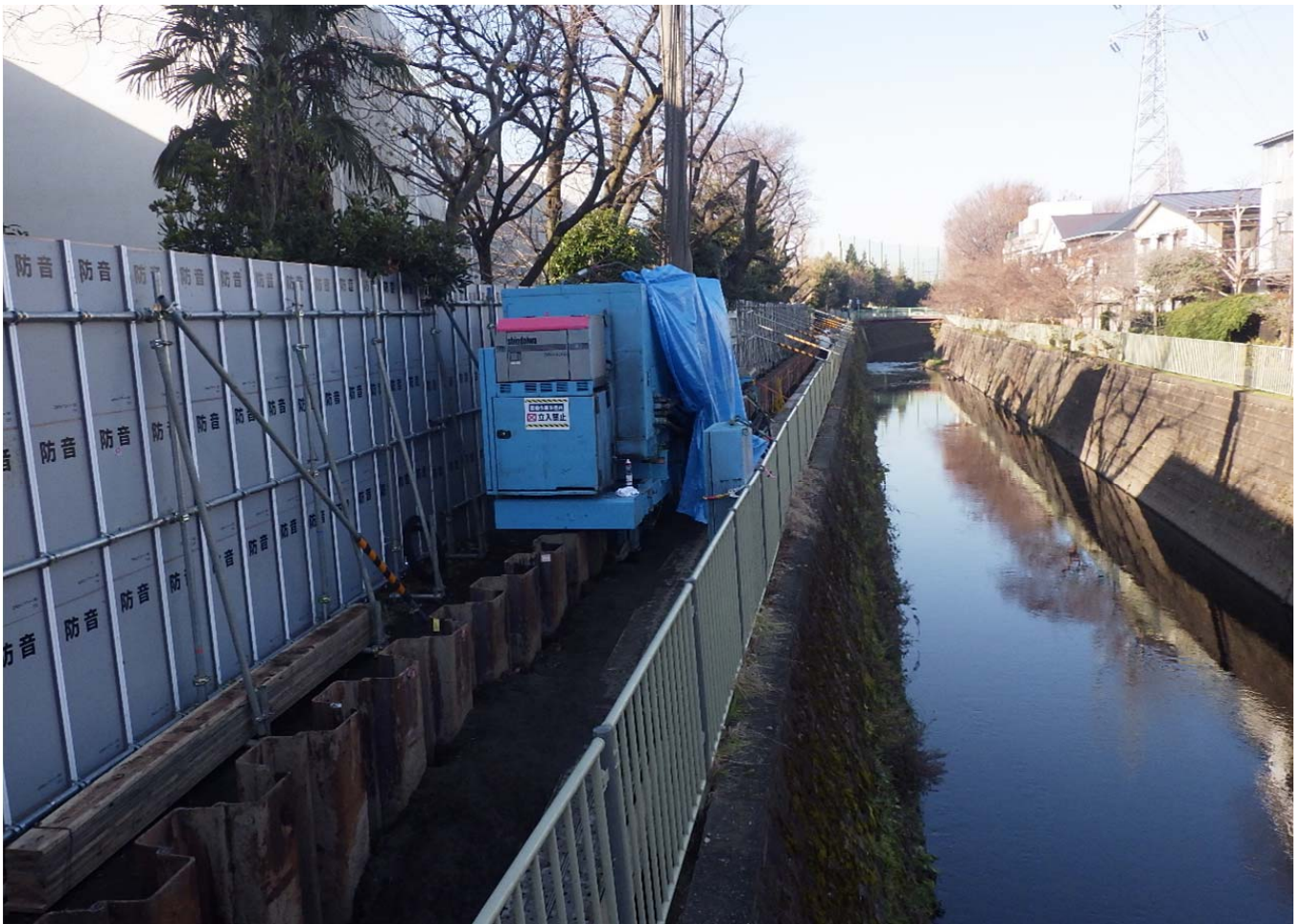
右岸上流側：鋼矢板工 圧入機後退状況
