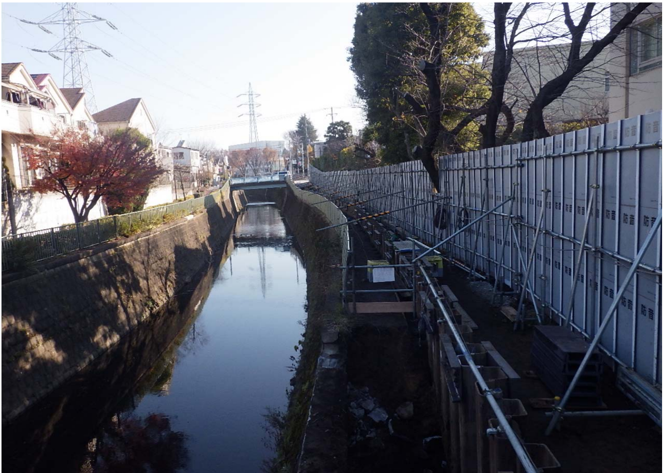
右岸下流側：栈橋設置工 桁受桁設置状況
