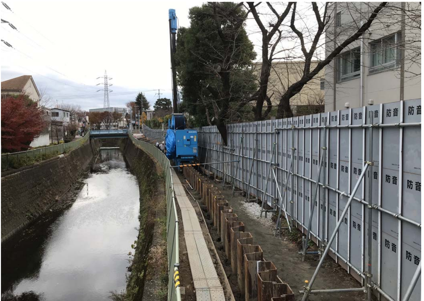
右岸下流側：鋼矢板圧入完了、機材後退状況
