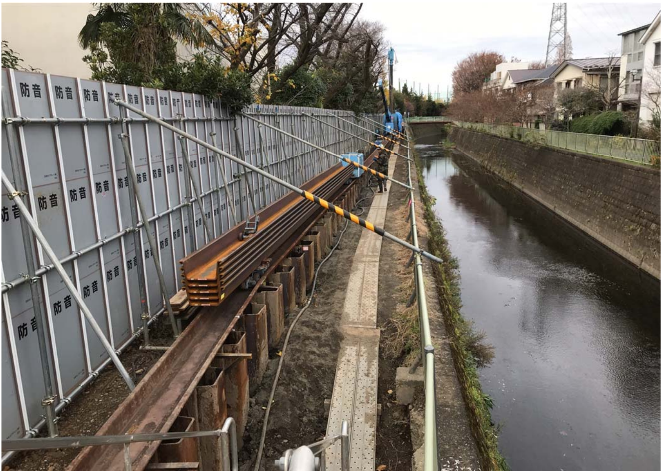
右岸上流側：鋼矢板圧入工（GRB工法）
