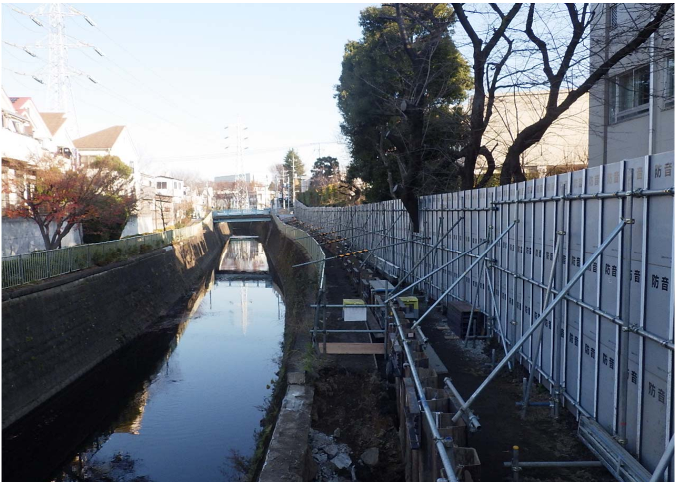
右岸下流側：構台設置工 桁受桁設置状況
