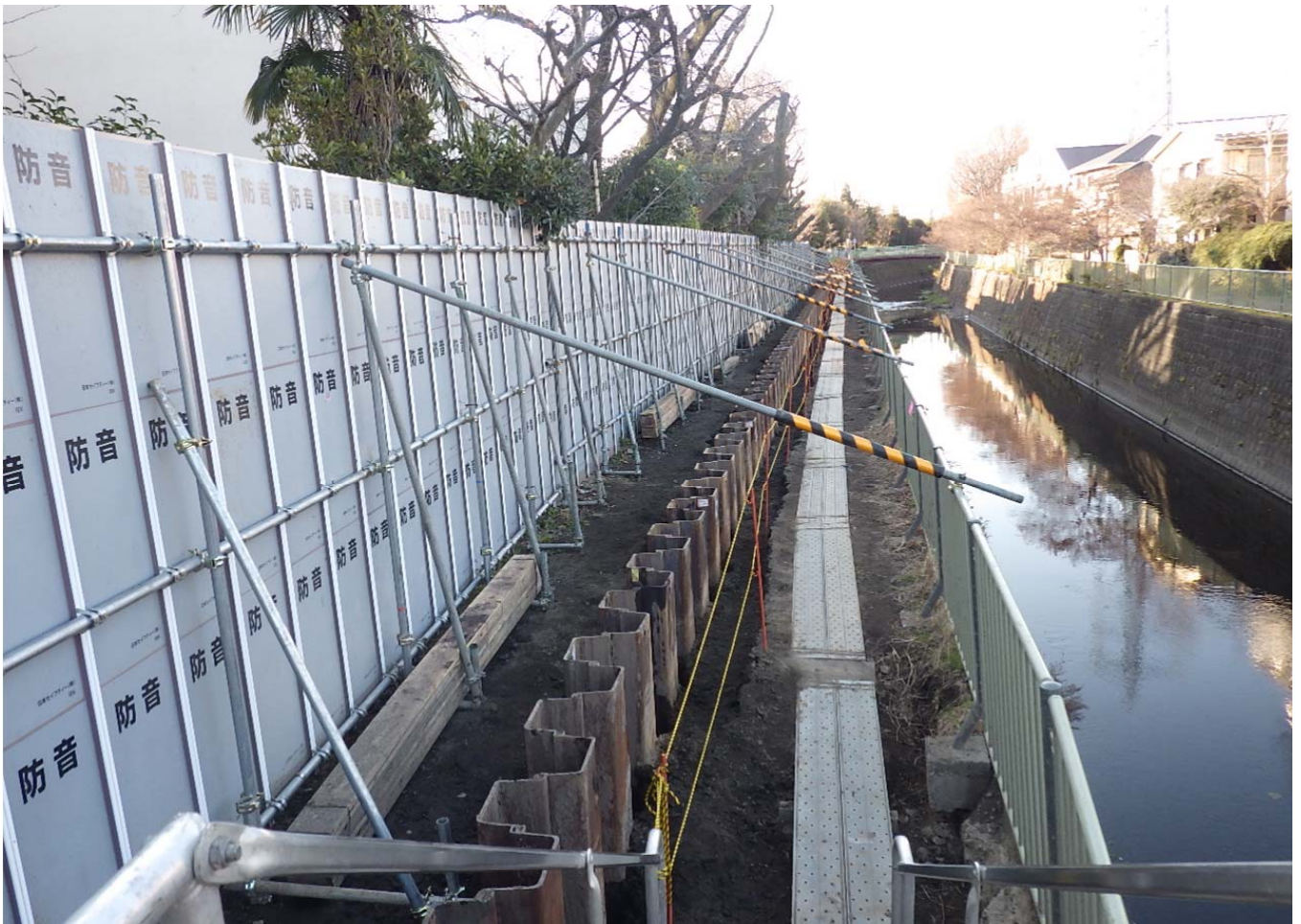
右岸上流側：鋼矢板工 圧入完了
