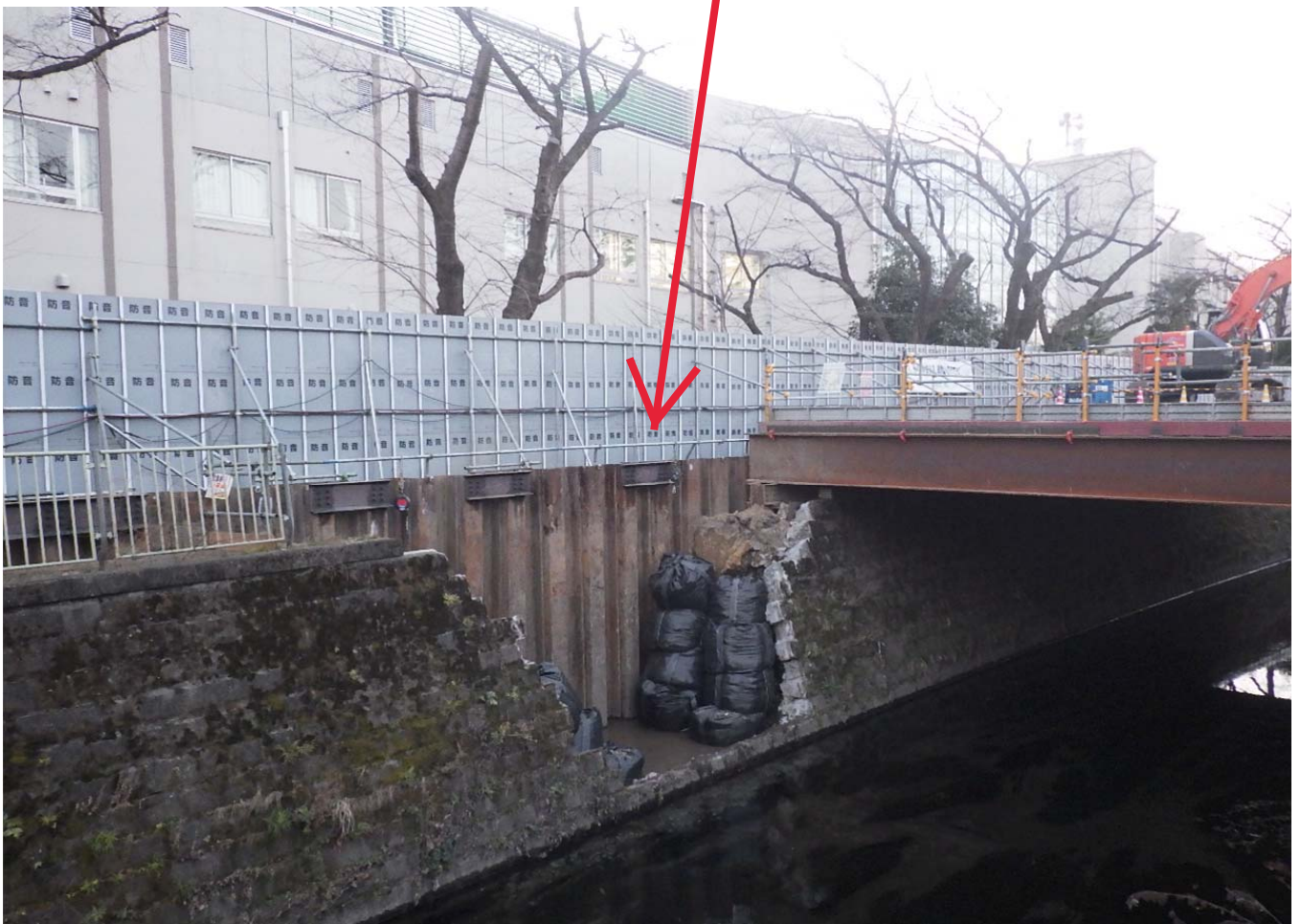
右岸下流側：護岸撤去状況
