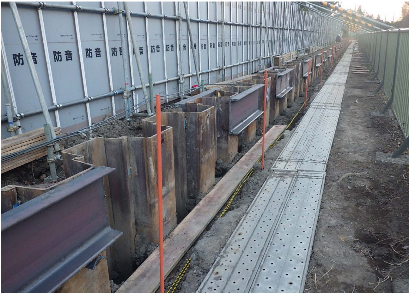
右岸上流側：桁受桁設置状況
