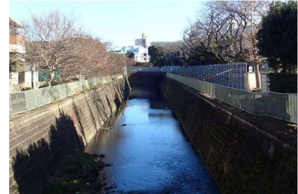
かなな橋より望む（上流側）
