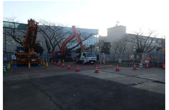
護岸撤去・掘削状況
