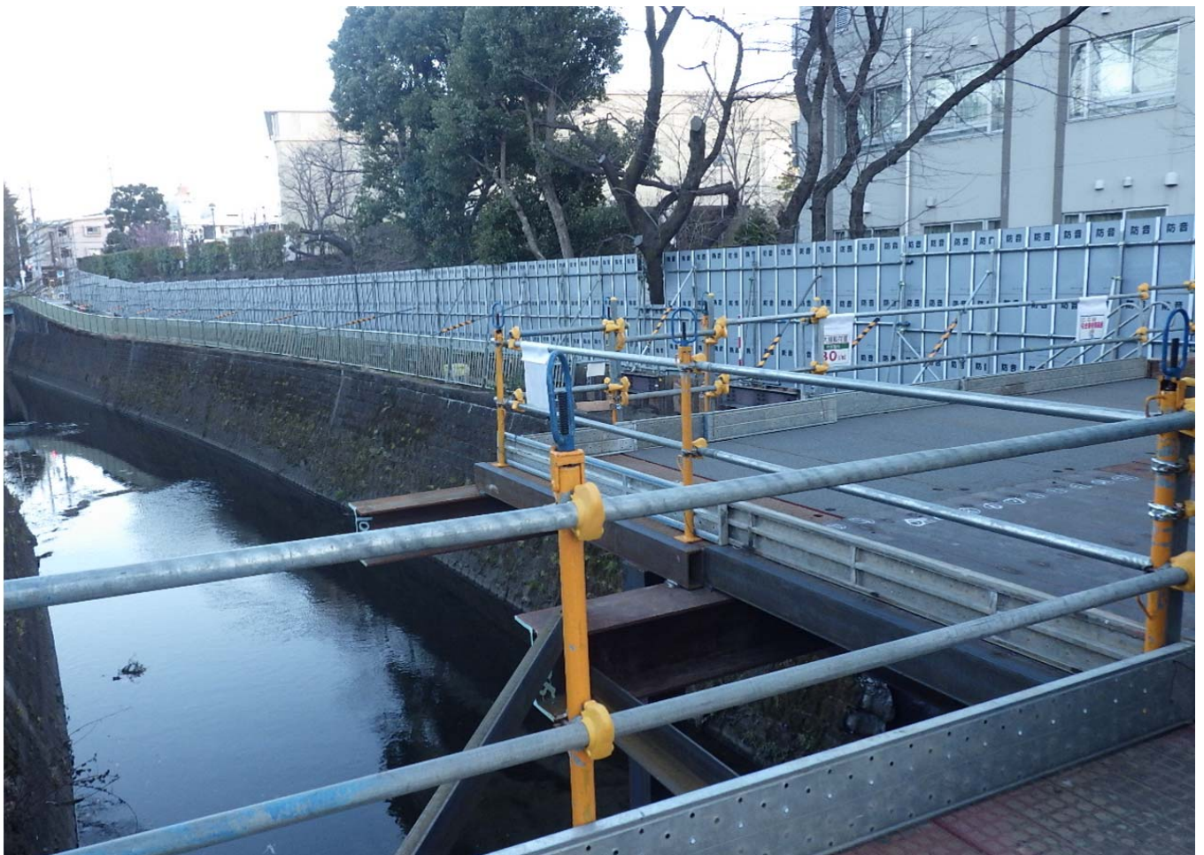
神田川下流：栈橋設置状況
