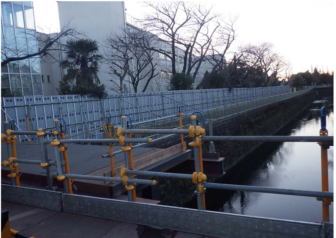
神田川上流：栈橋設置状況
