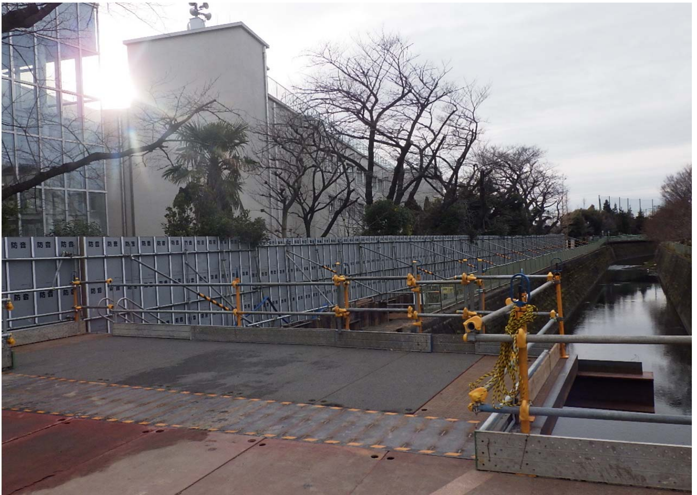
栈橋構台よりかな橋側：栈橋設置工、護岸撤去工
