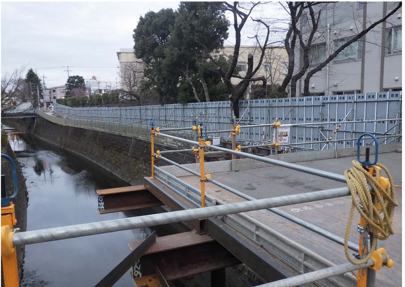
栈橋構台より永福橋側：栈橋設置工、護岸撤去工
