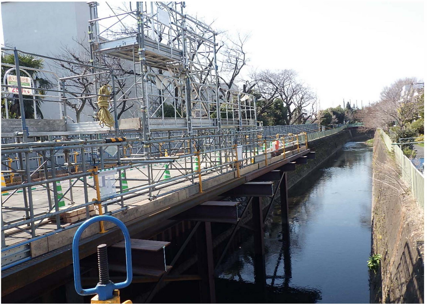
栈橋構台よりかんな橋側：護岸撤去・栈橋設置工
