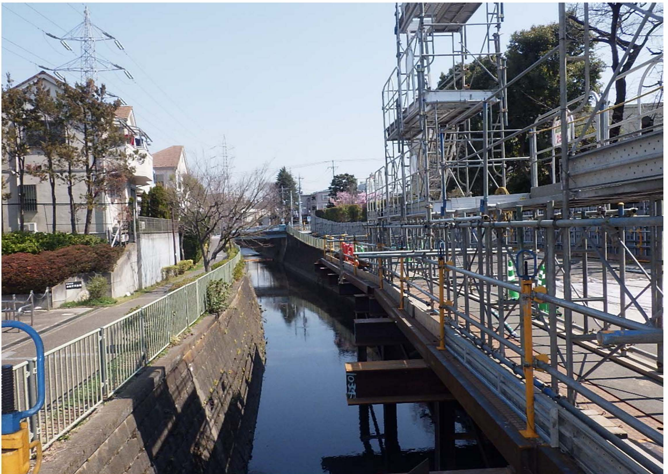
栈橋構台より永福橋側：護岸撤去・栈橋設置工
