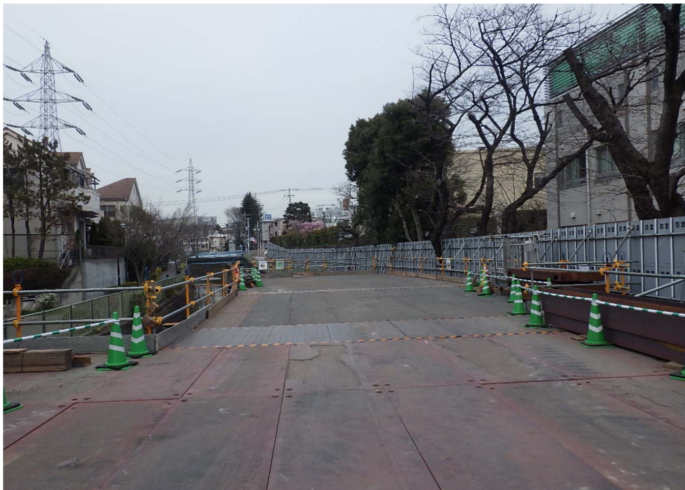
栈橋構台より永福橋側：栈橋設置工 23m設置完了
