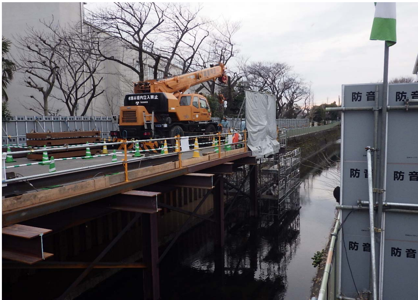
栈橋構台よりかな橋側：栈橋設置工 29m設置完了
