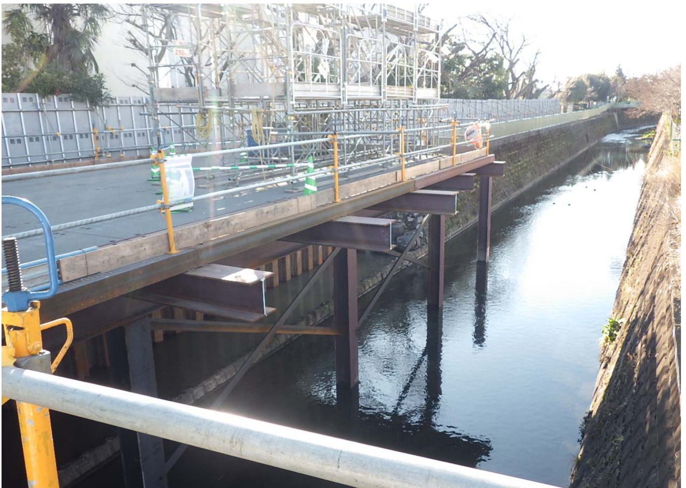
構台よりかな橋側：栈橋設置工・護岸撤去工
