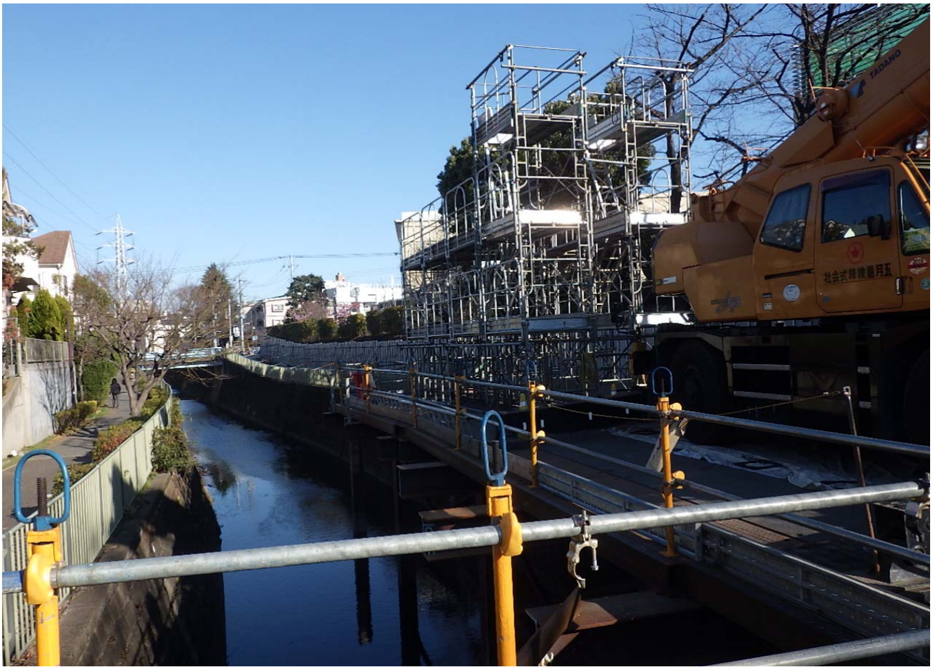
構台より永福橋側：栈橋設置工・護岸撤去工
