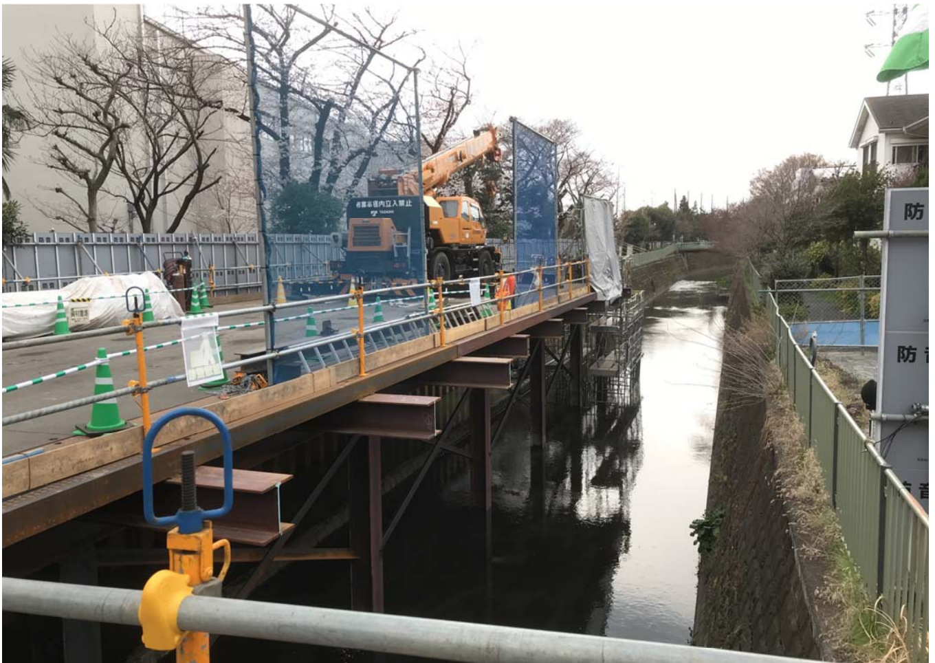
栈橋構台よりかな橋側：護岸撤去・栈橋設置工 34m設置
