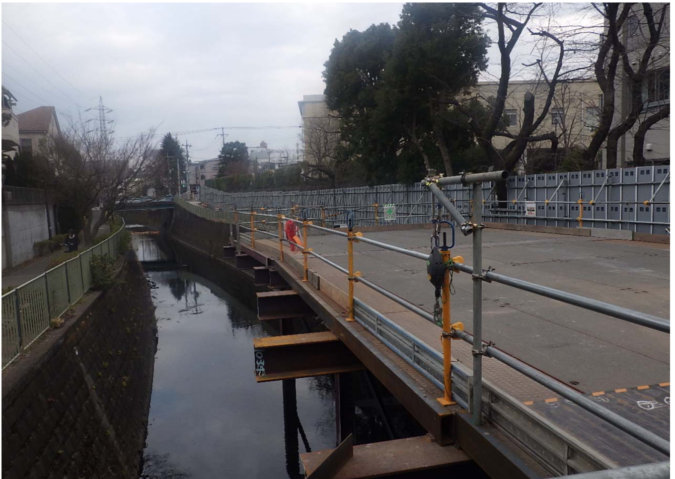
栈橋構台より永福橋側：護岸撤去・栈橋設置状況
