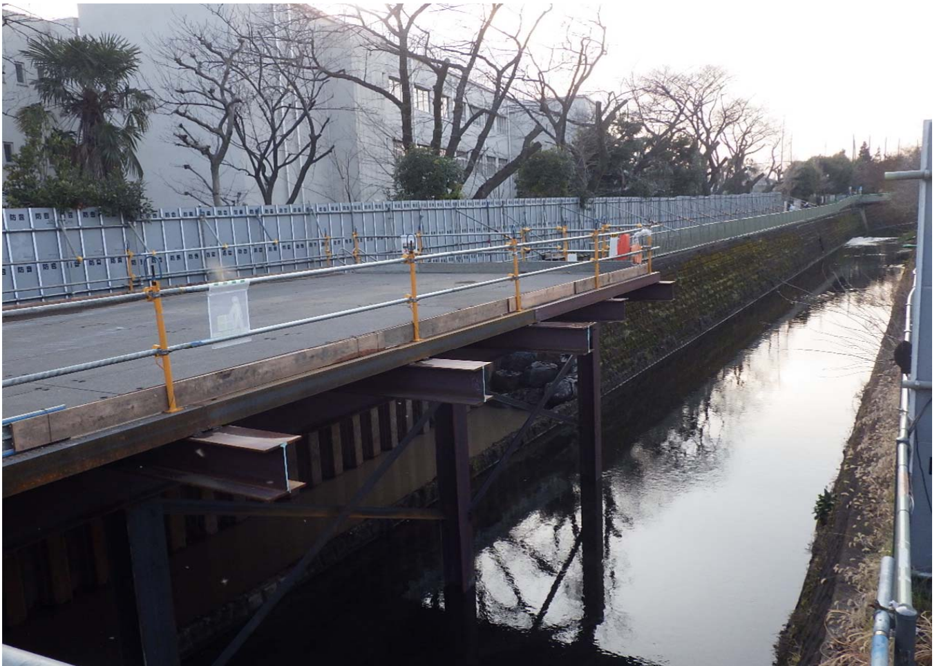
栈橋構台よりかな橋側：護岸撤去・栈橋設置状況
