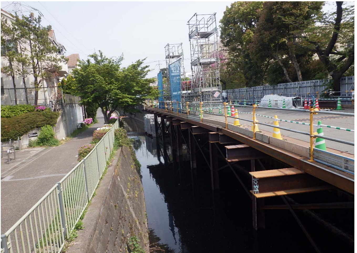
栈橋構台より永福橋側：護岸撤去・栈橋設置工 46m設置
