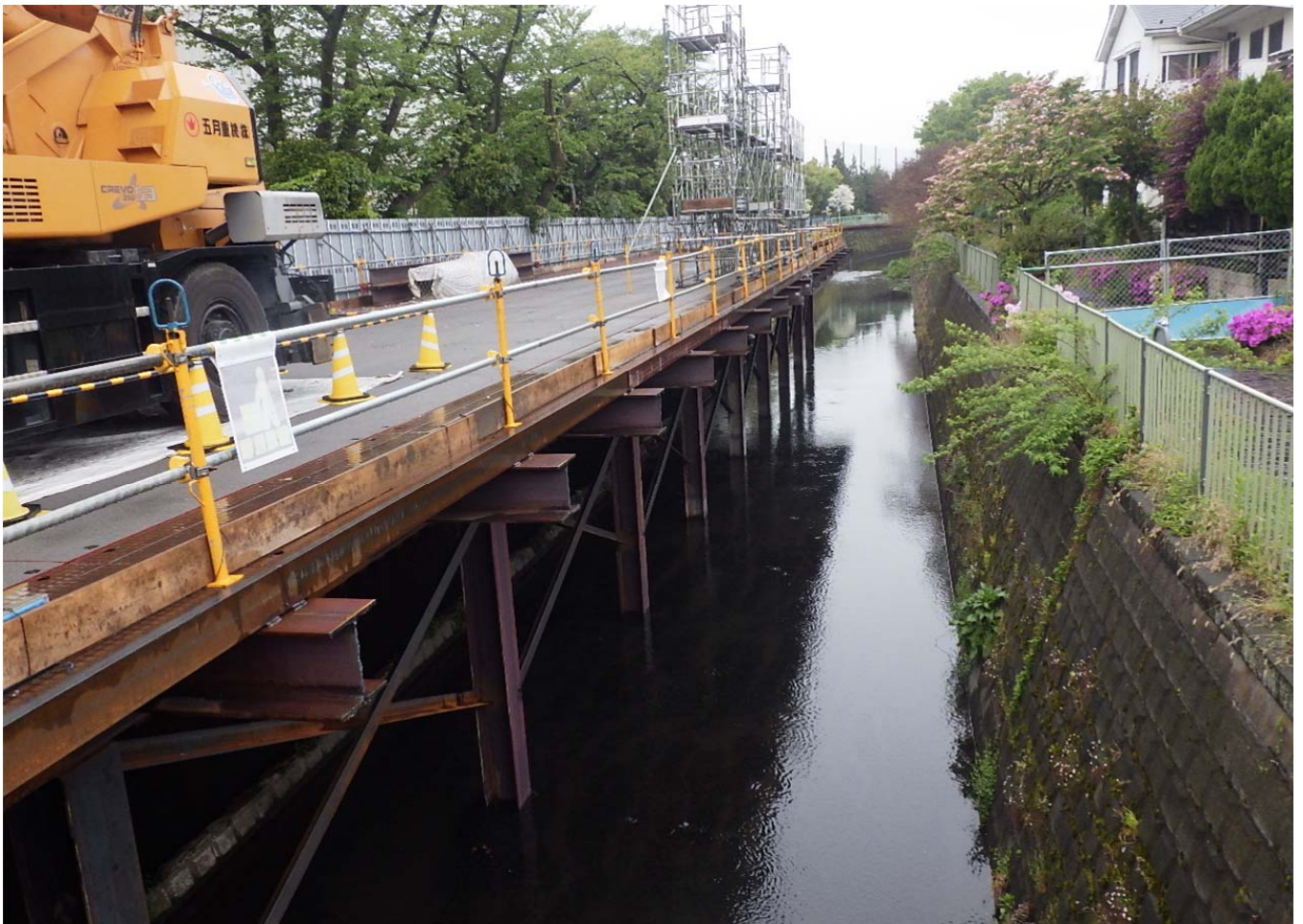
栈橋構台よりかな橋側：護岸撤去・栈橋設置工 52m
