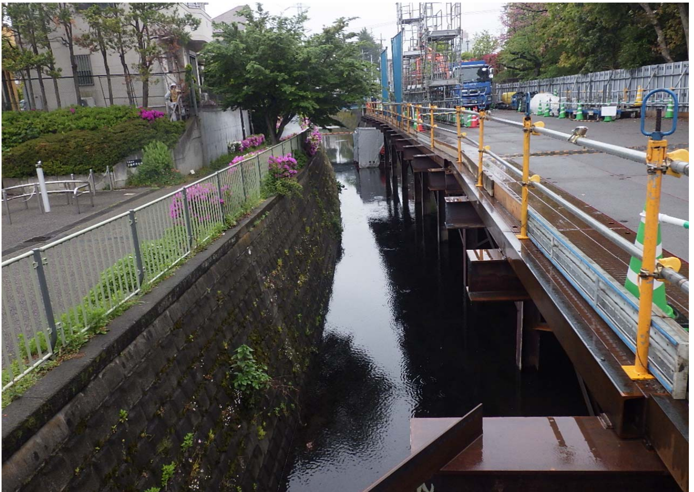
栈橋構台より永福橋側：護岸撤去・栈橋設置工 52m
