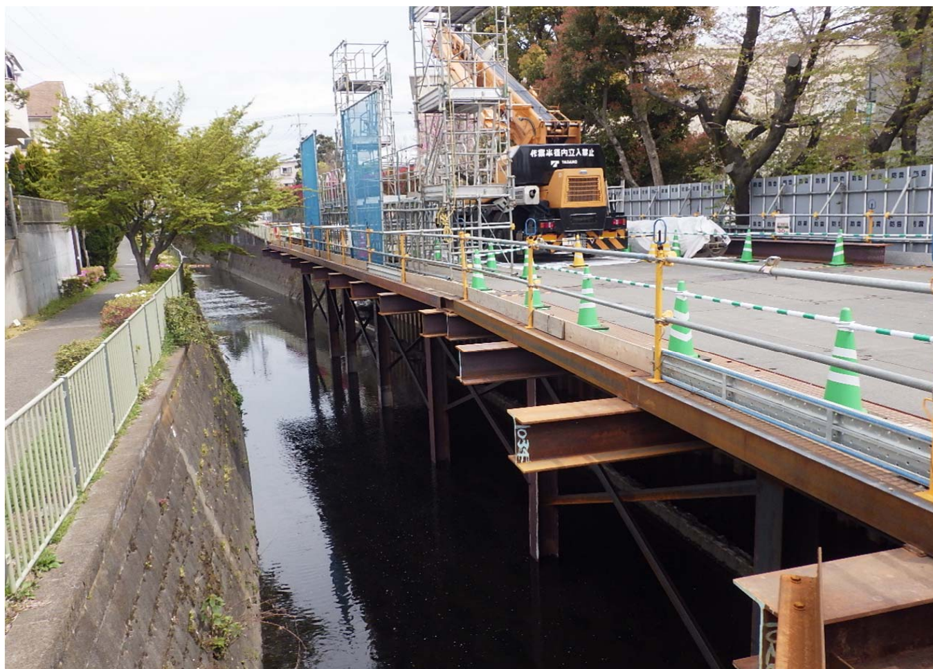
栈橋構台より永福橋側：護岸撤去工・栈橋設置工
