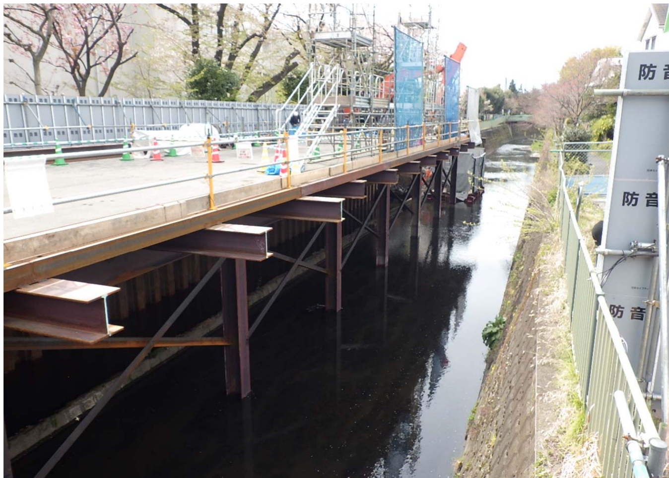
栈橋構台よりかな橋側：護岸撤去工・栈橋設置工
