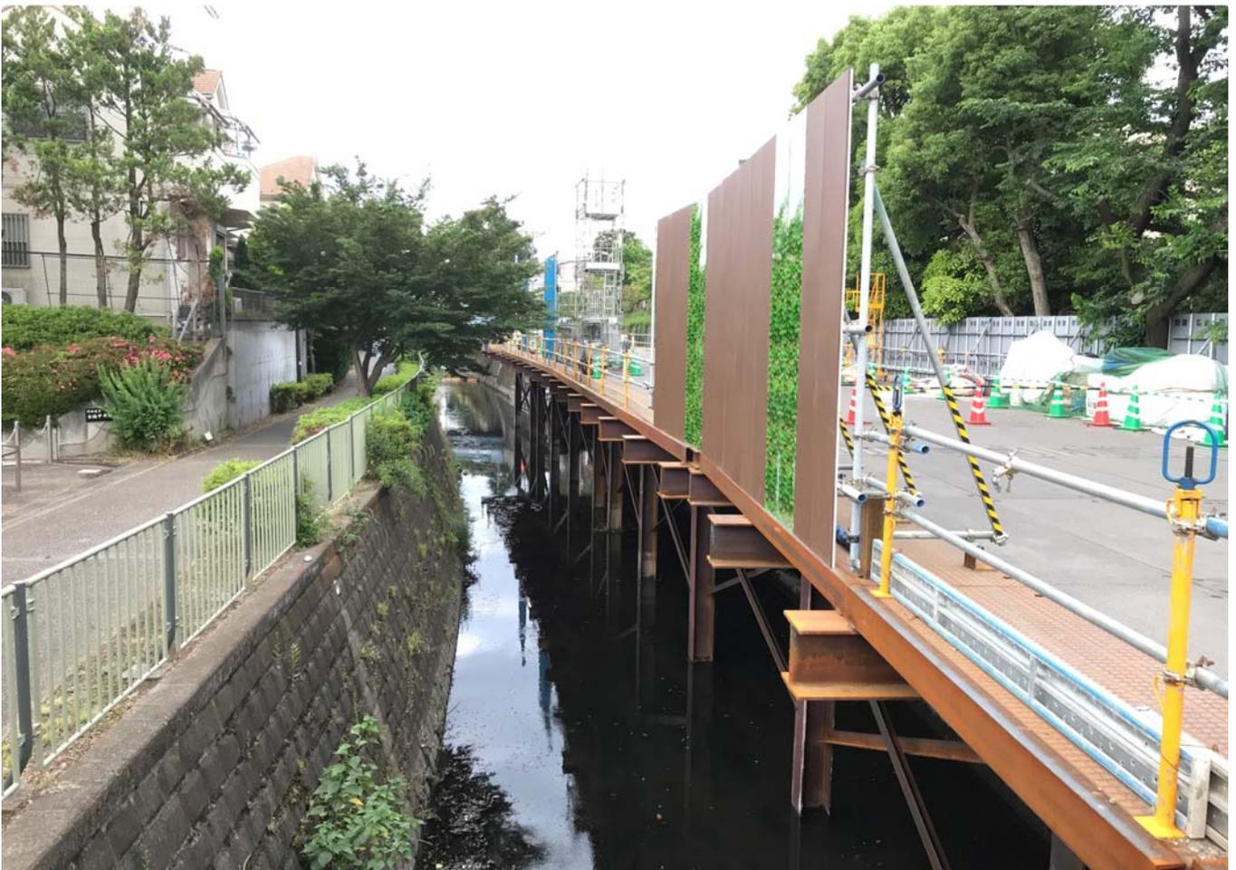
永福橋側：栈橋設置工、護岸撤去工 約60m設置
