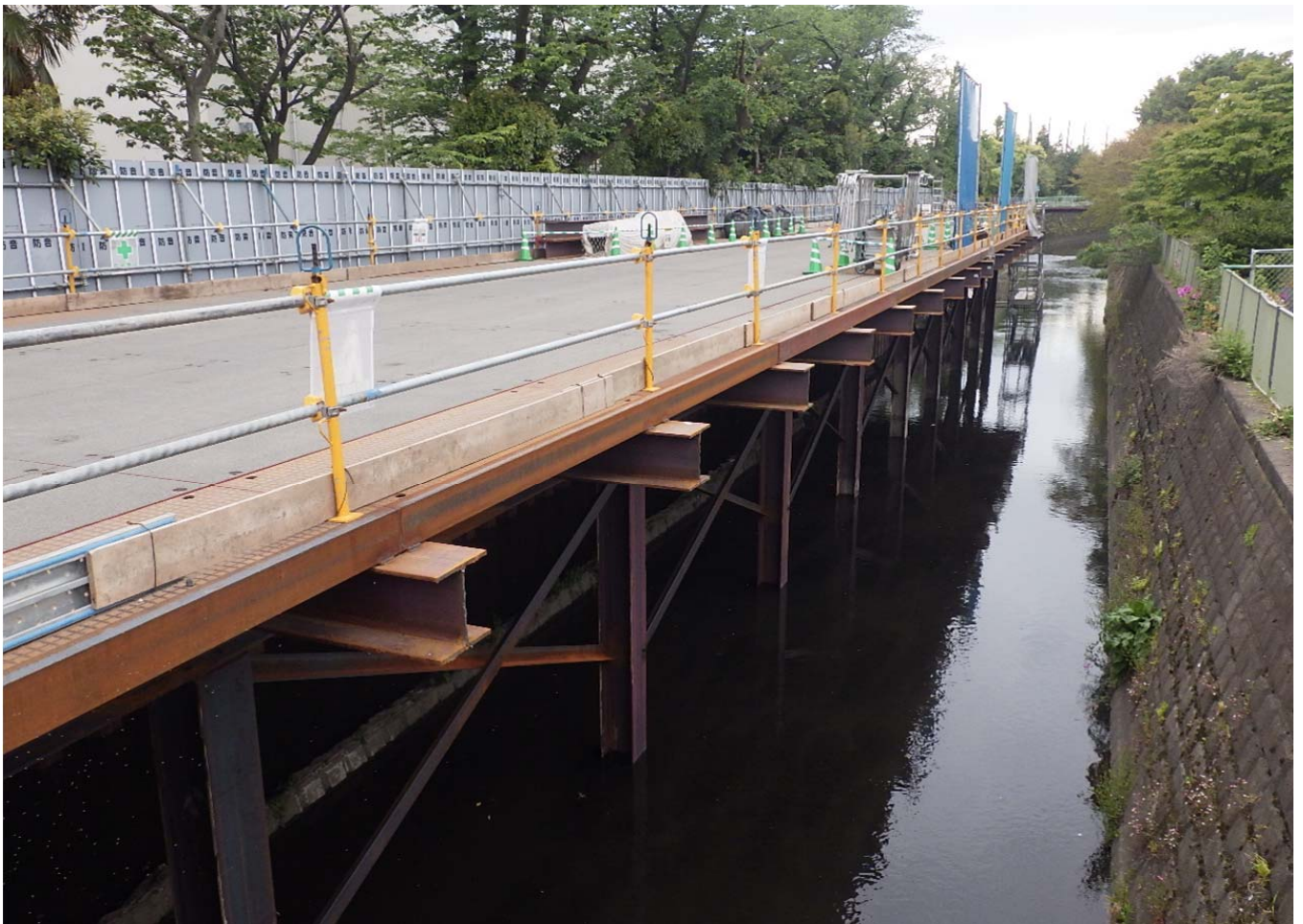
栈橋構台よりかな橋側：栈橋設置工・護岸撤去工 52m完了
