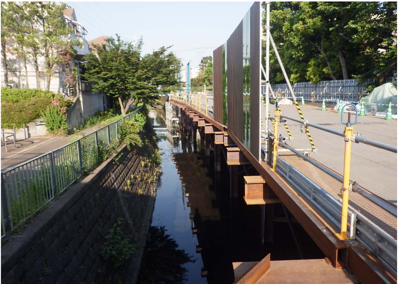
栈橋構台より永福橋側：栈橋設置・護岸撤去工 5.5 m設置
