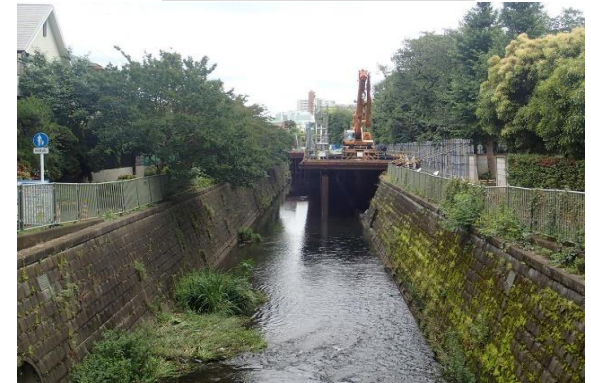
かなな橋より望む(上流側)
