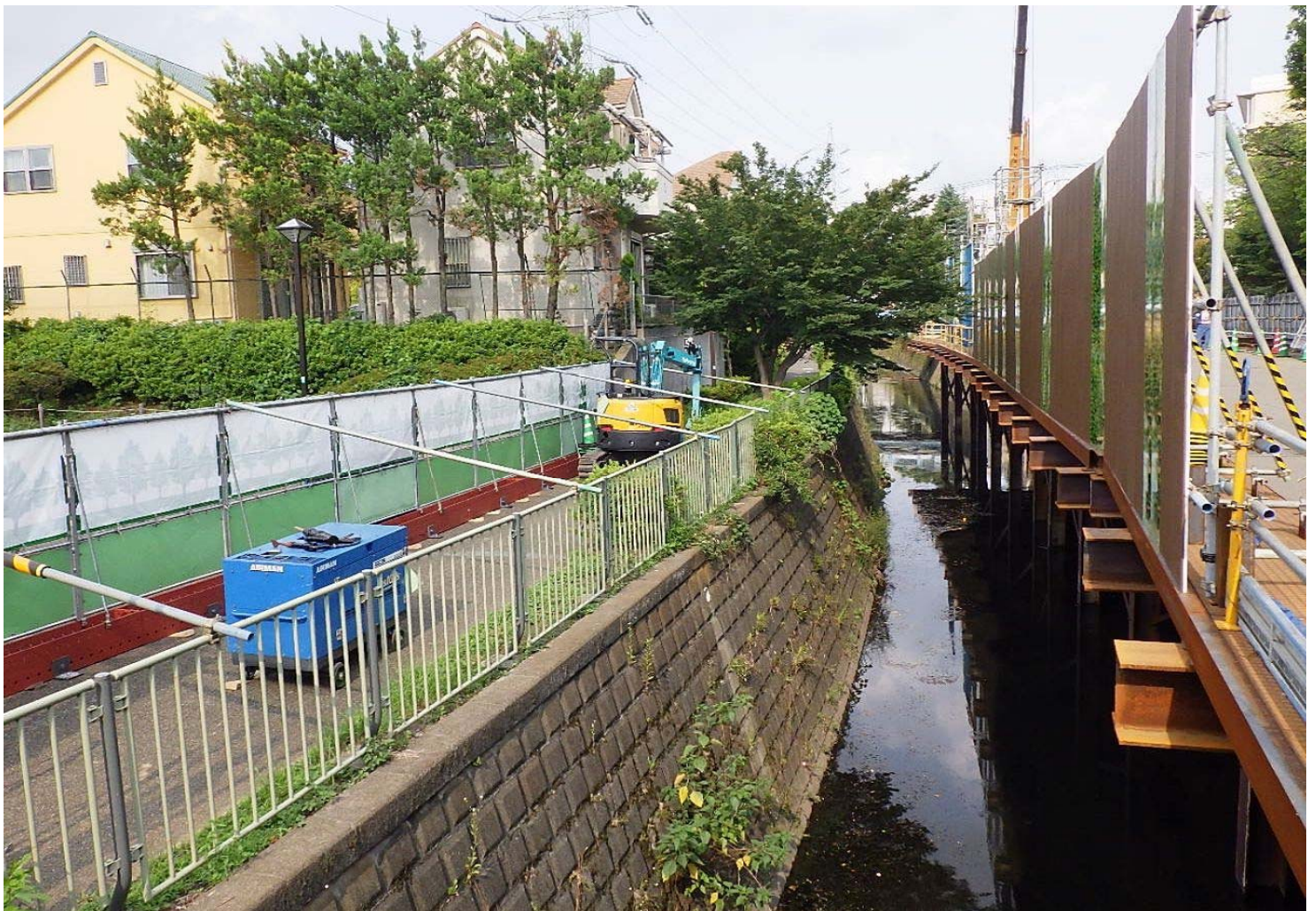
永福橋側：栈橋設置、護岸撤去工 65m完了
