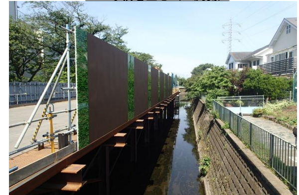
かなな橋を望む(上流側)
