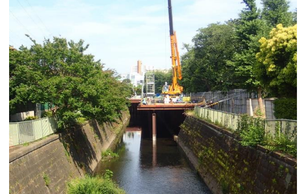
かなな橋より望む(上流側)
