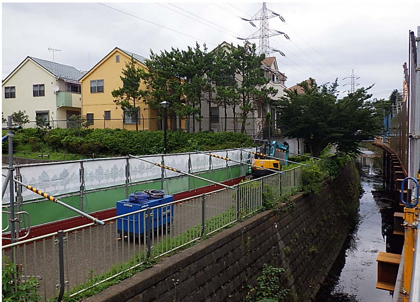
永福橋側：栈橋設置・護岸撤去工 70m完了
