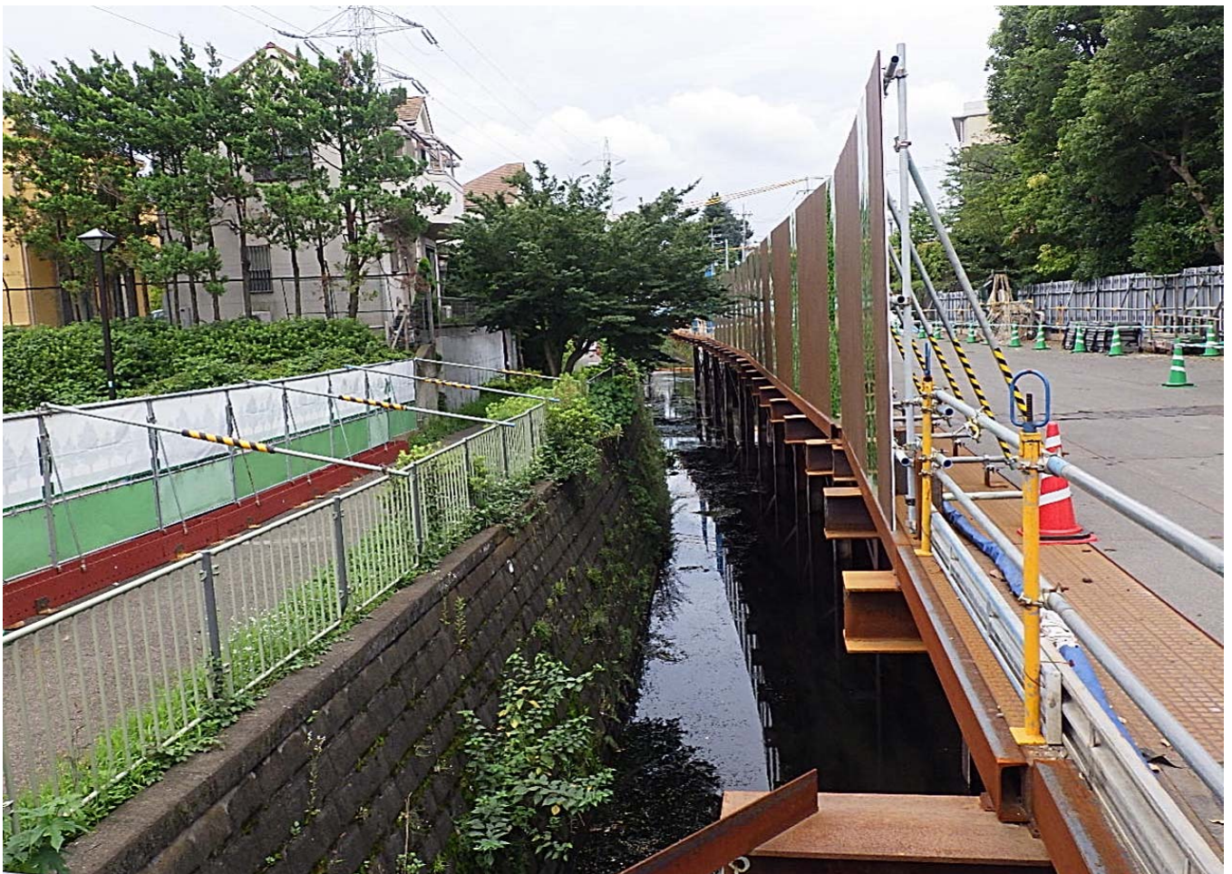
かな橋側：栈橋設置・護岸撤去工 85m完了
