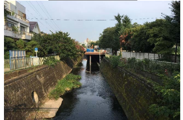
上流側 かな橋より望む
