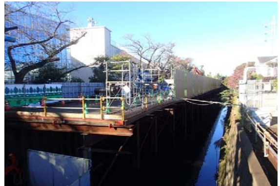
施工用栈橋 上流を望む
