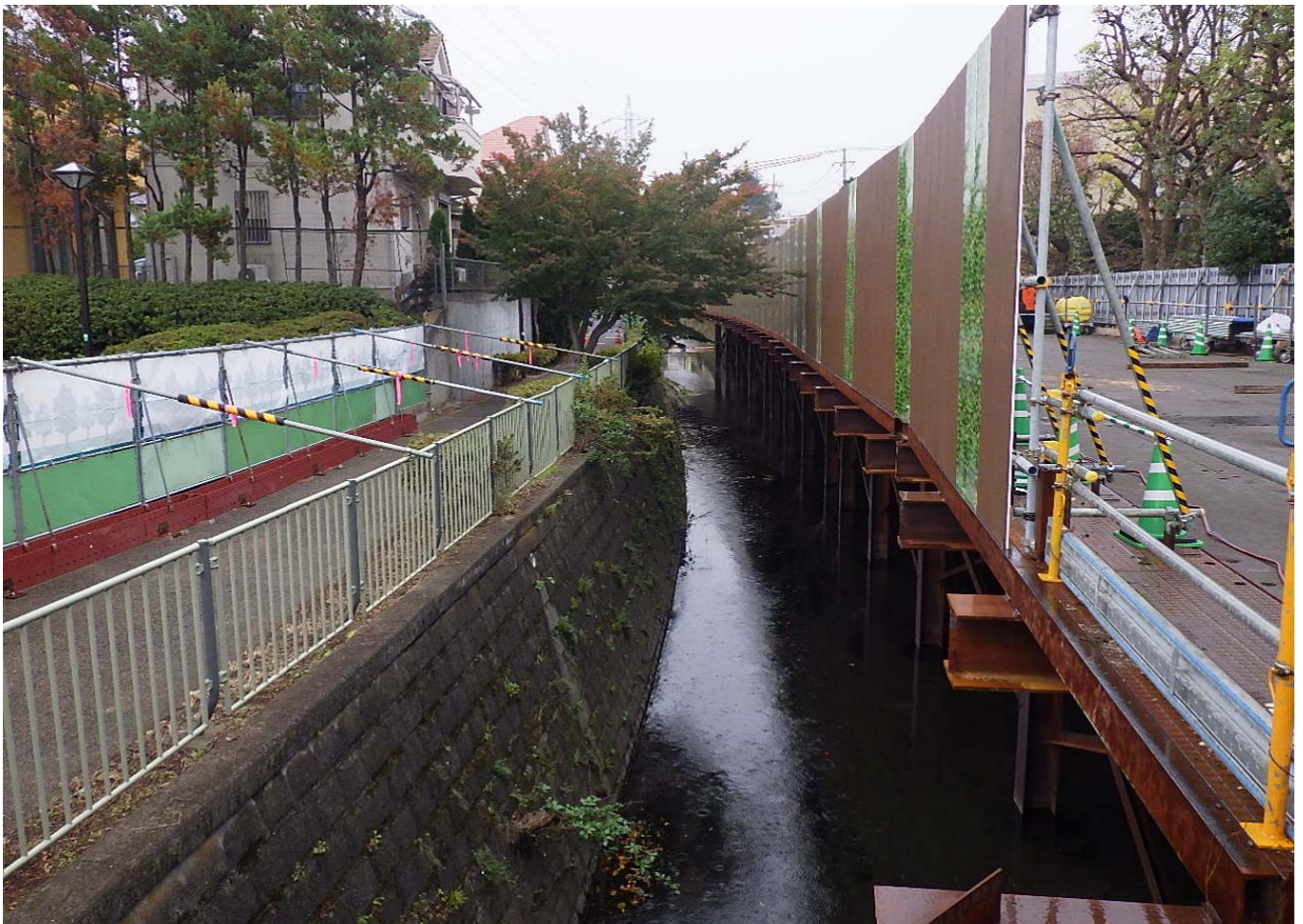
永福橋側：栈橋設置・護岸撤去工 完了
