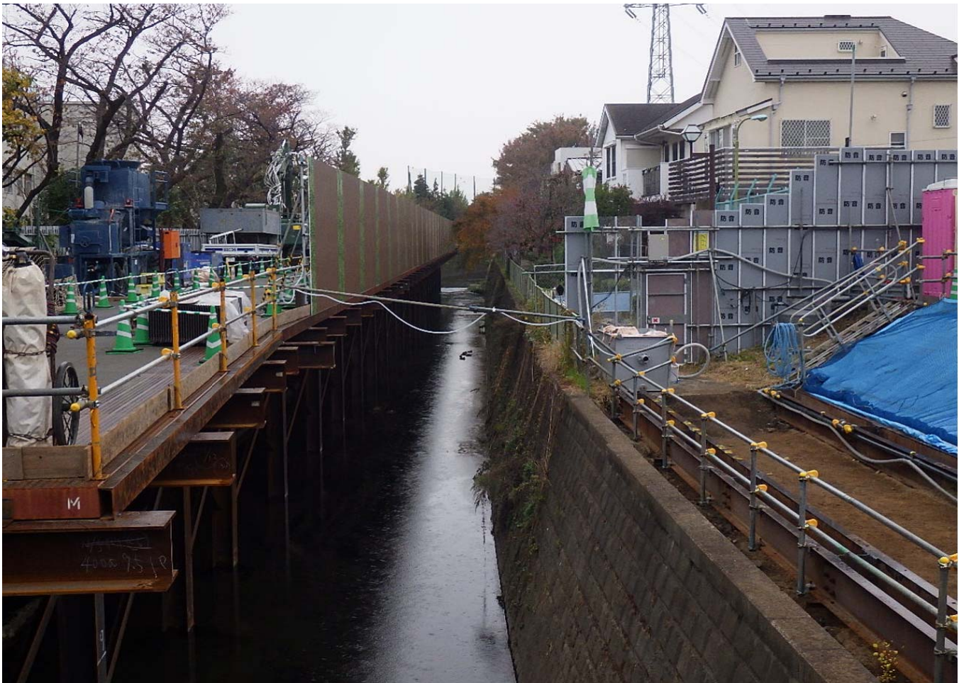
かな橋側：栈橋設置・護岸撤去工 完了、中央部18m解体、17m新設
