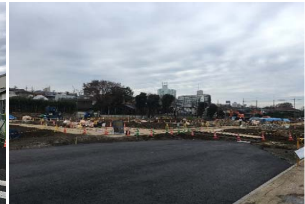
調節池ヤード(西側)を望む
