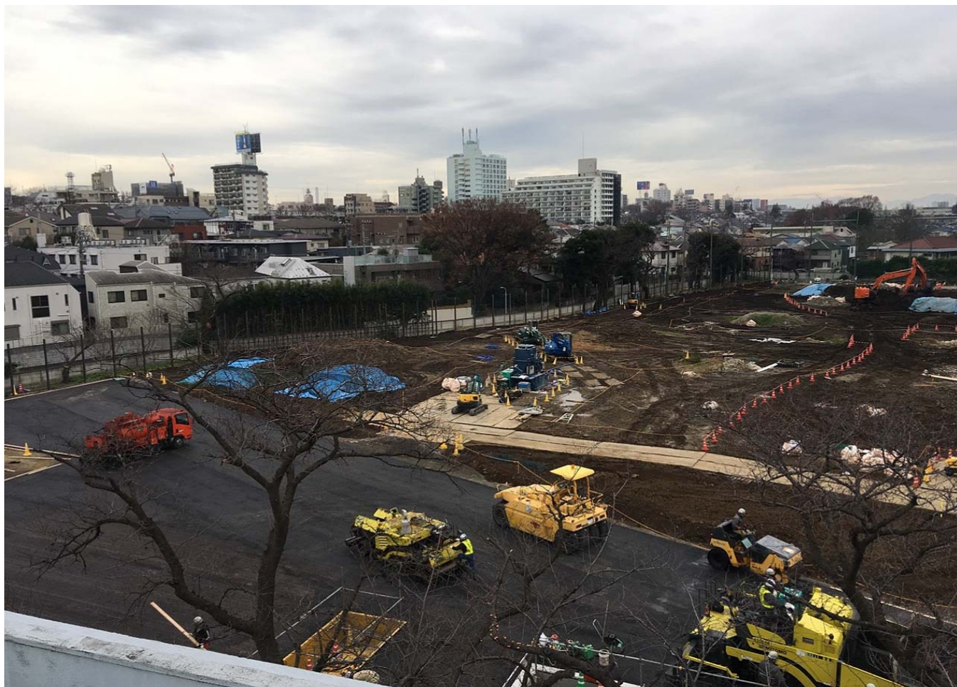
調節池ヤード 南東側を望む
