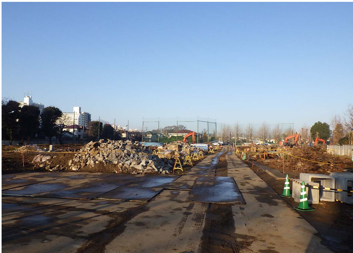
調節池ヤード 東側を望む
