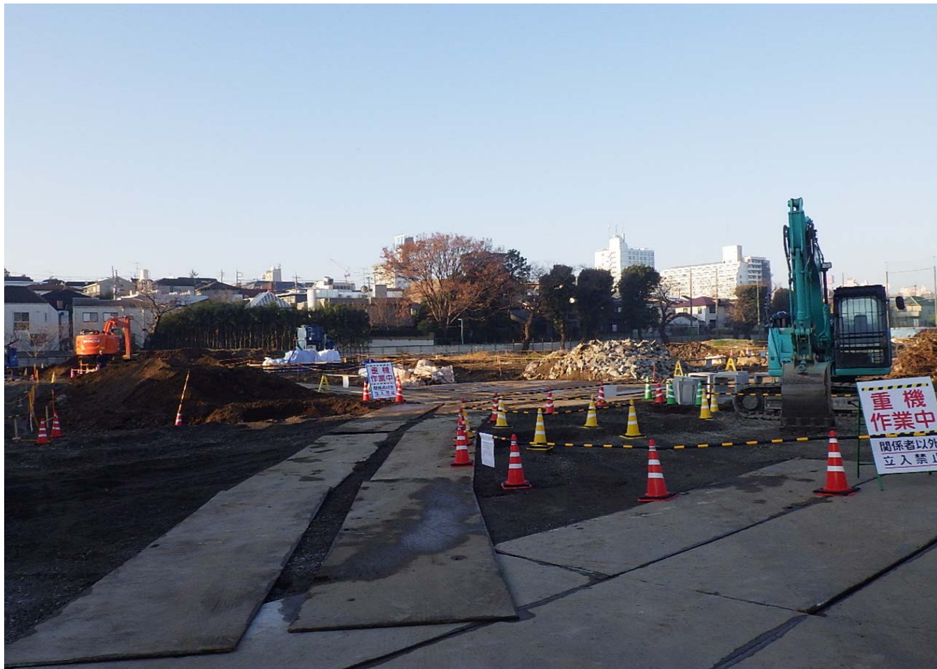
調節池ヤード 棧橋から南側を望む
