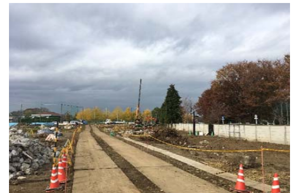
調節池ヤード（西側）を望む
