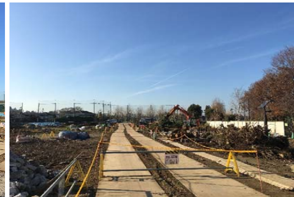
調節池ヤード（西側）を望む
