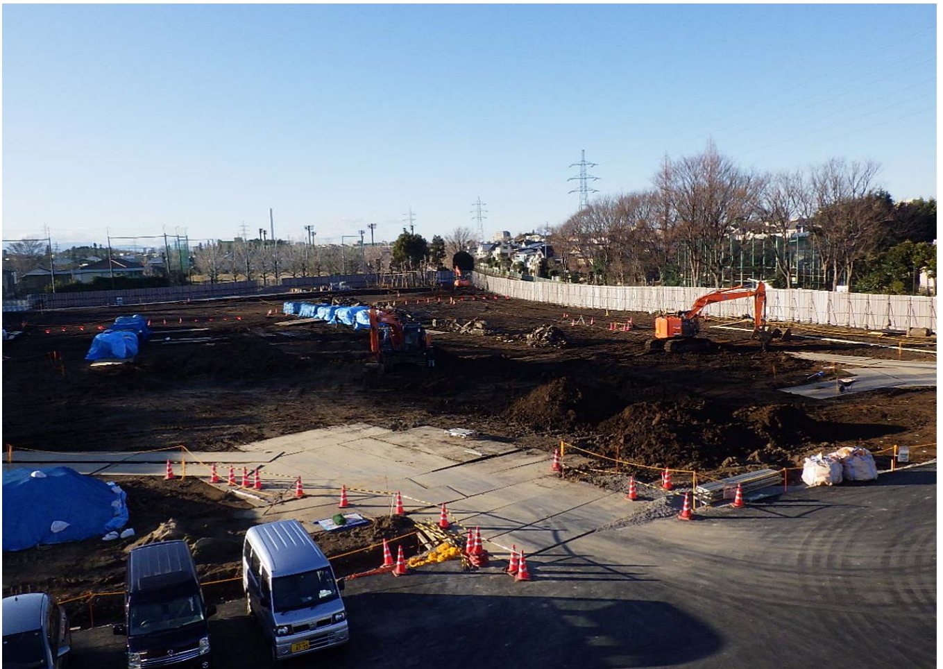
調節池ヤード 西側を望む
