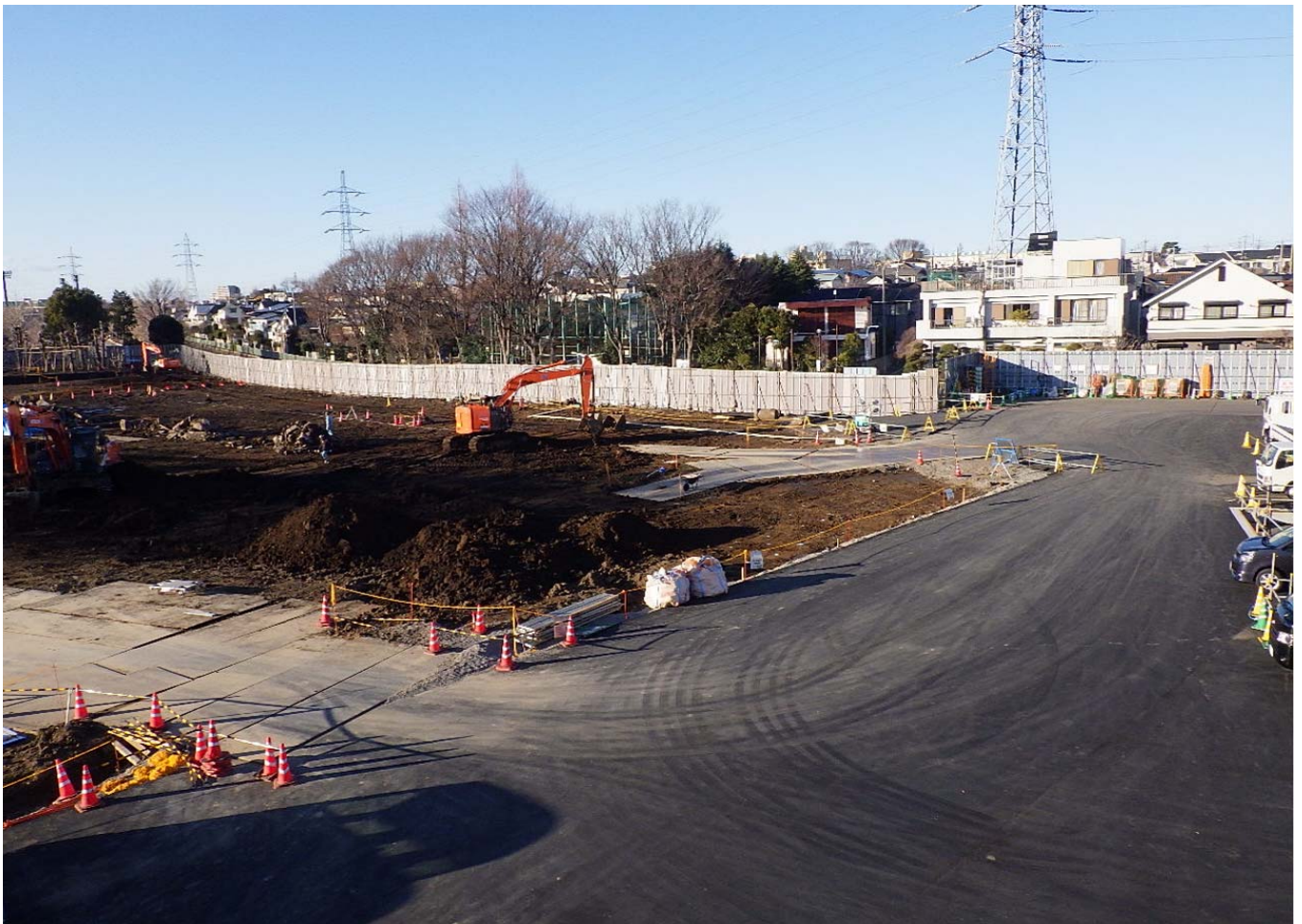
調節池ヤード 北西側を望む
