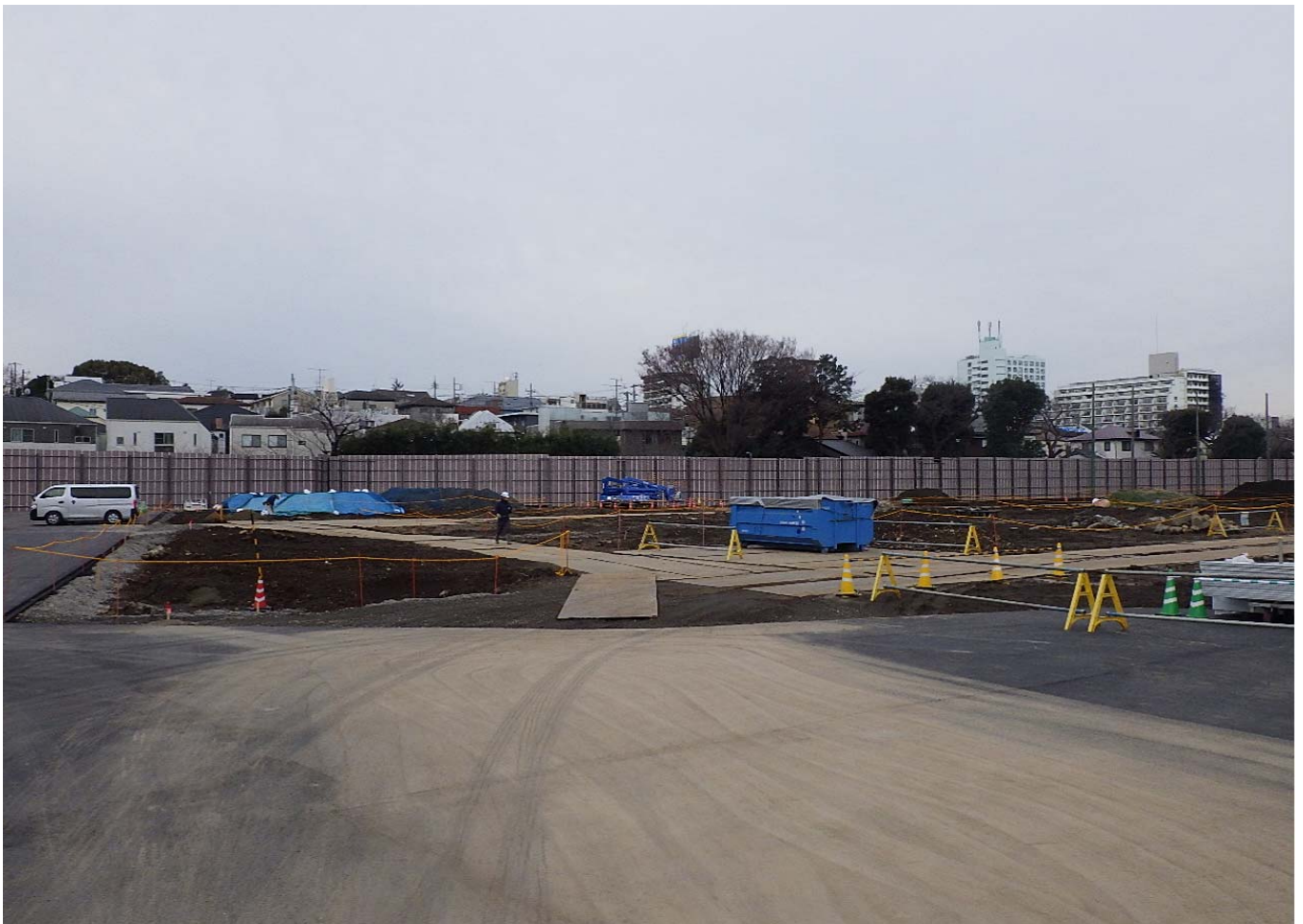
調節池ヤード 東側を望む
