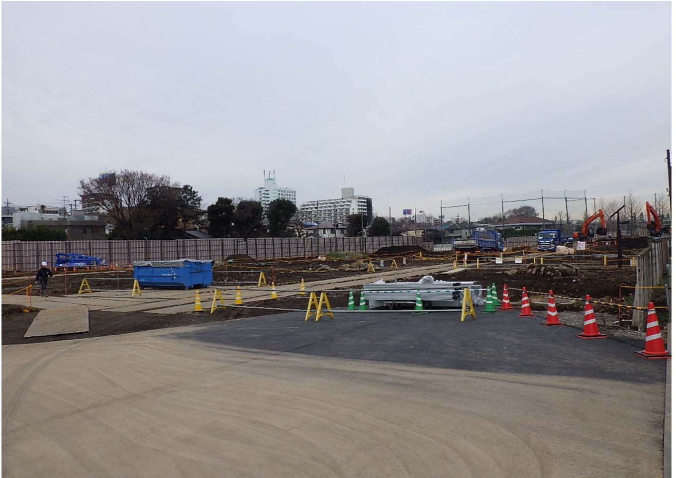
調節池ヤード 西側を望む
