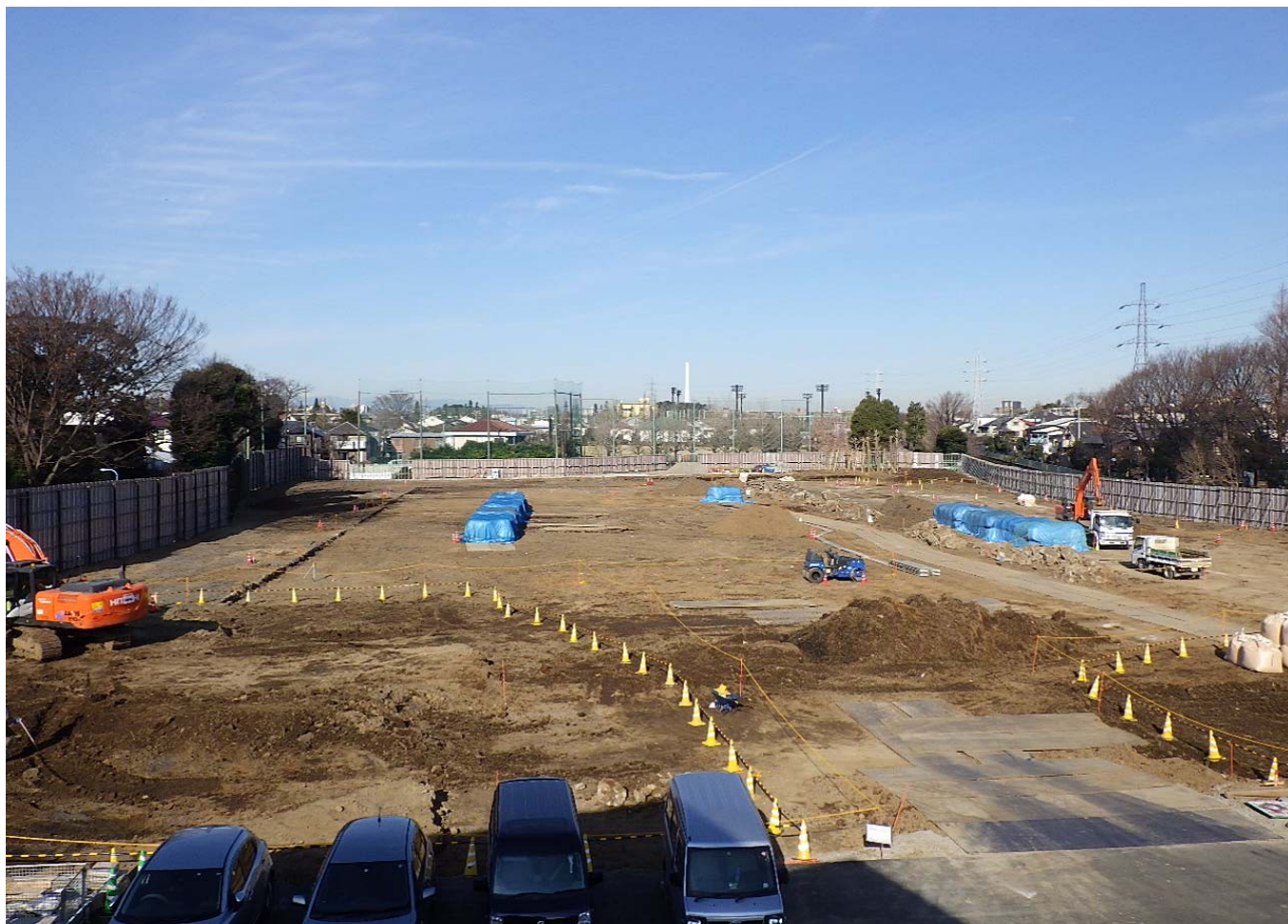
調節池ヤード 西側を望む
