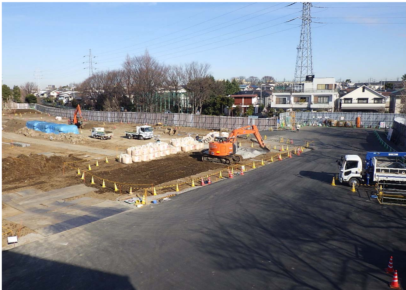
調節池ヤード 北西側を望む
