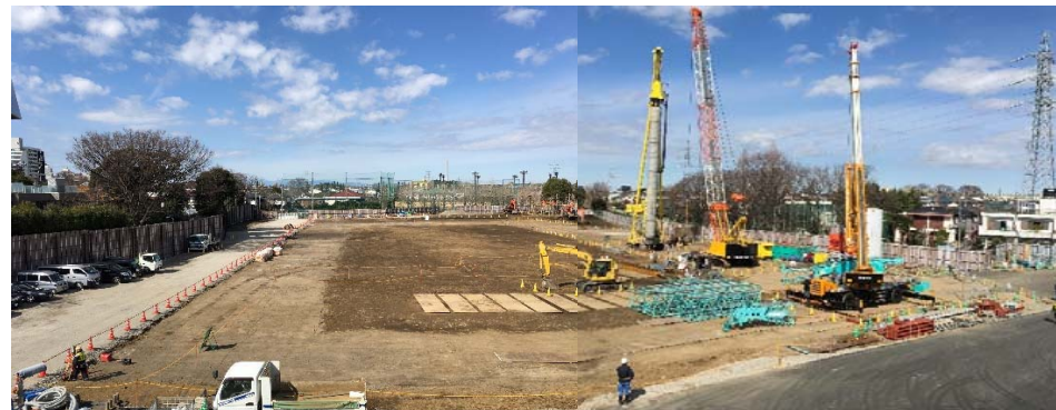
地中連続壁工 杭打機組立
