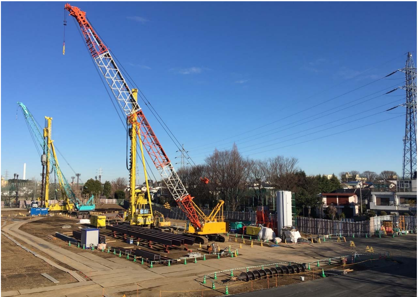
調節池ヤード 北西側を望む
