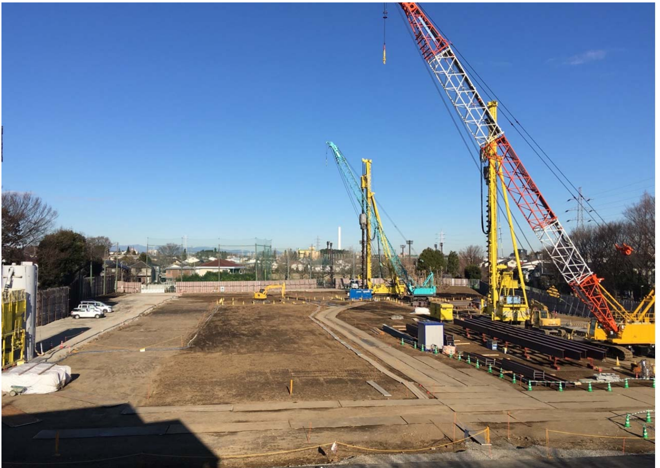
調節池ヤード 西側を望む
