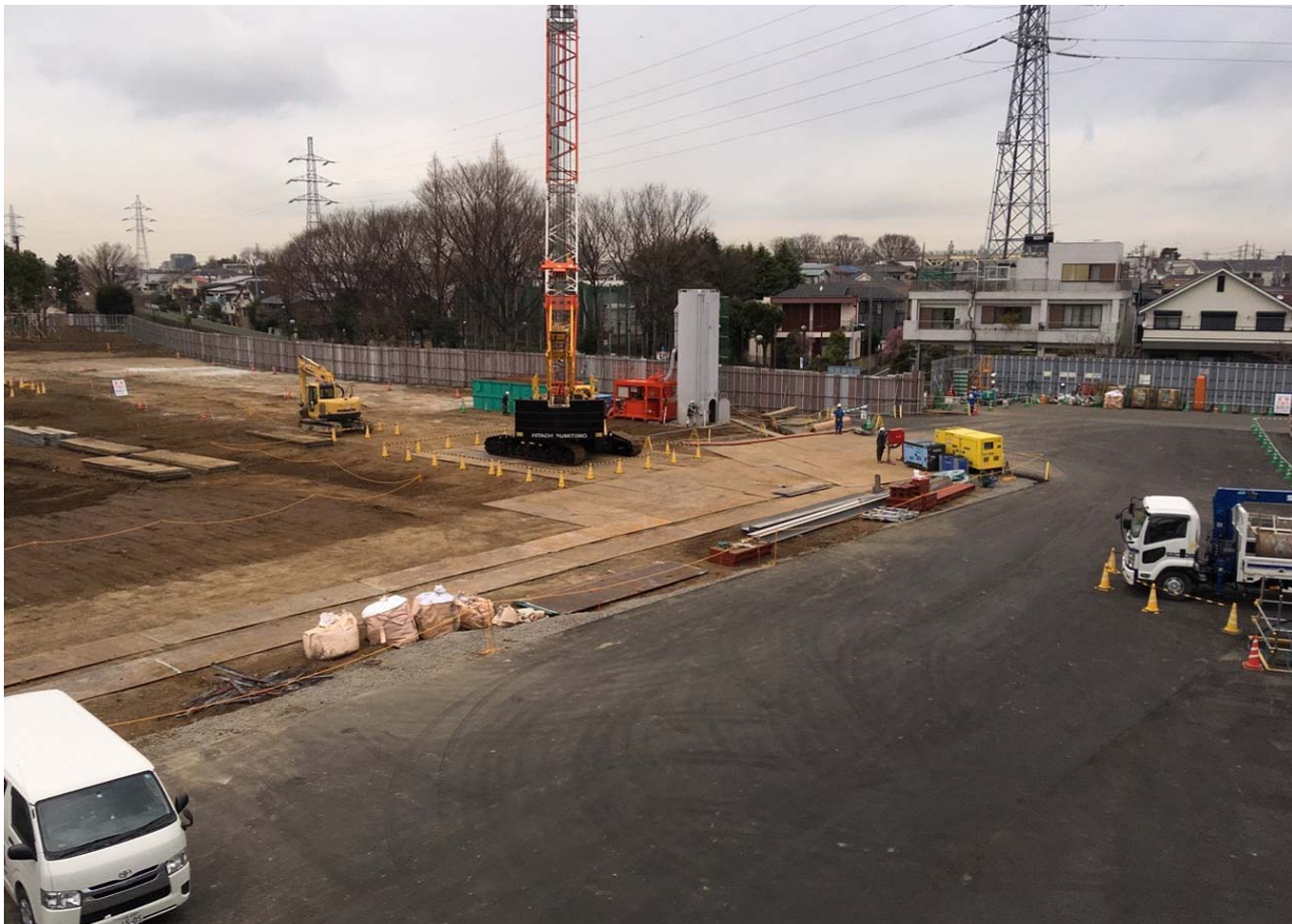
調節池ヤード 北西側を望む
