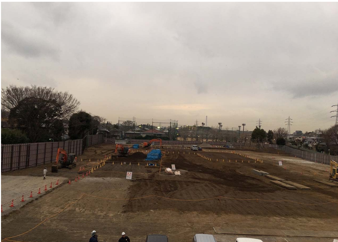
調節池ヤード 西側を望む
