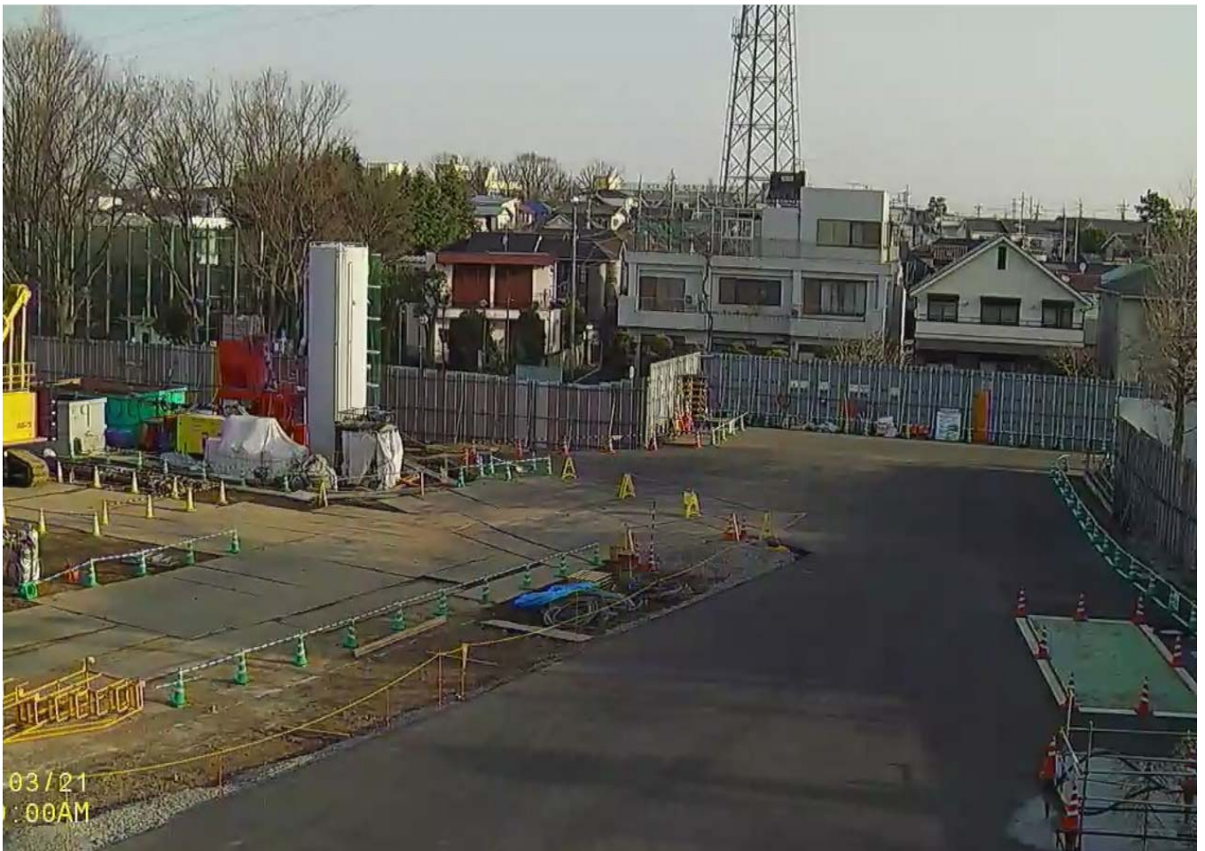
調節池ヤード 西側を望む
