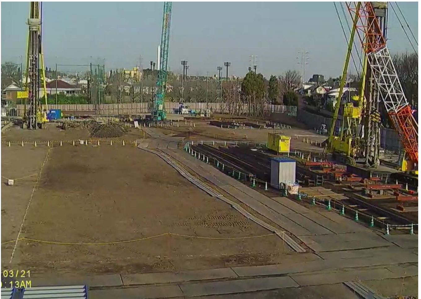
調節池ヤード 東側を望む
