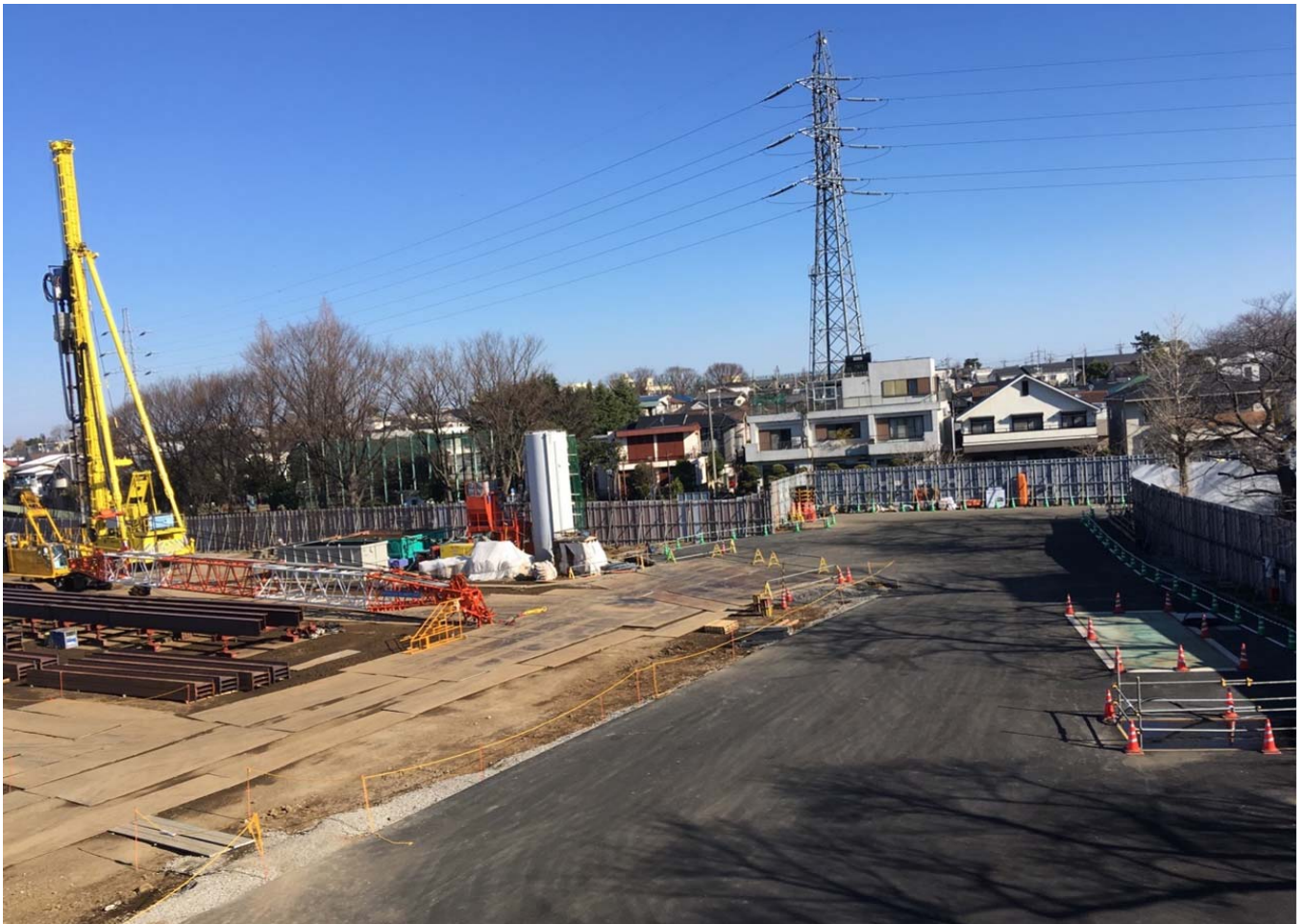
調節池ヤード 東側を望む
