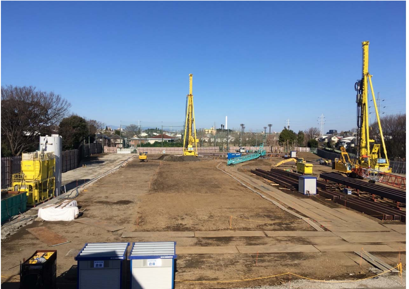
調節池ヤード 西側を望む
