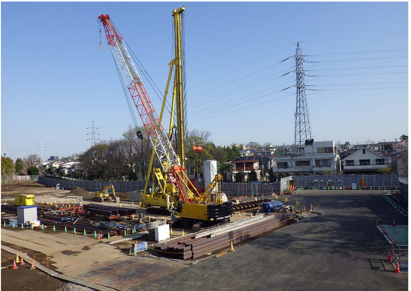
調節池ヤード 東側を望む
