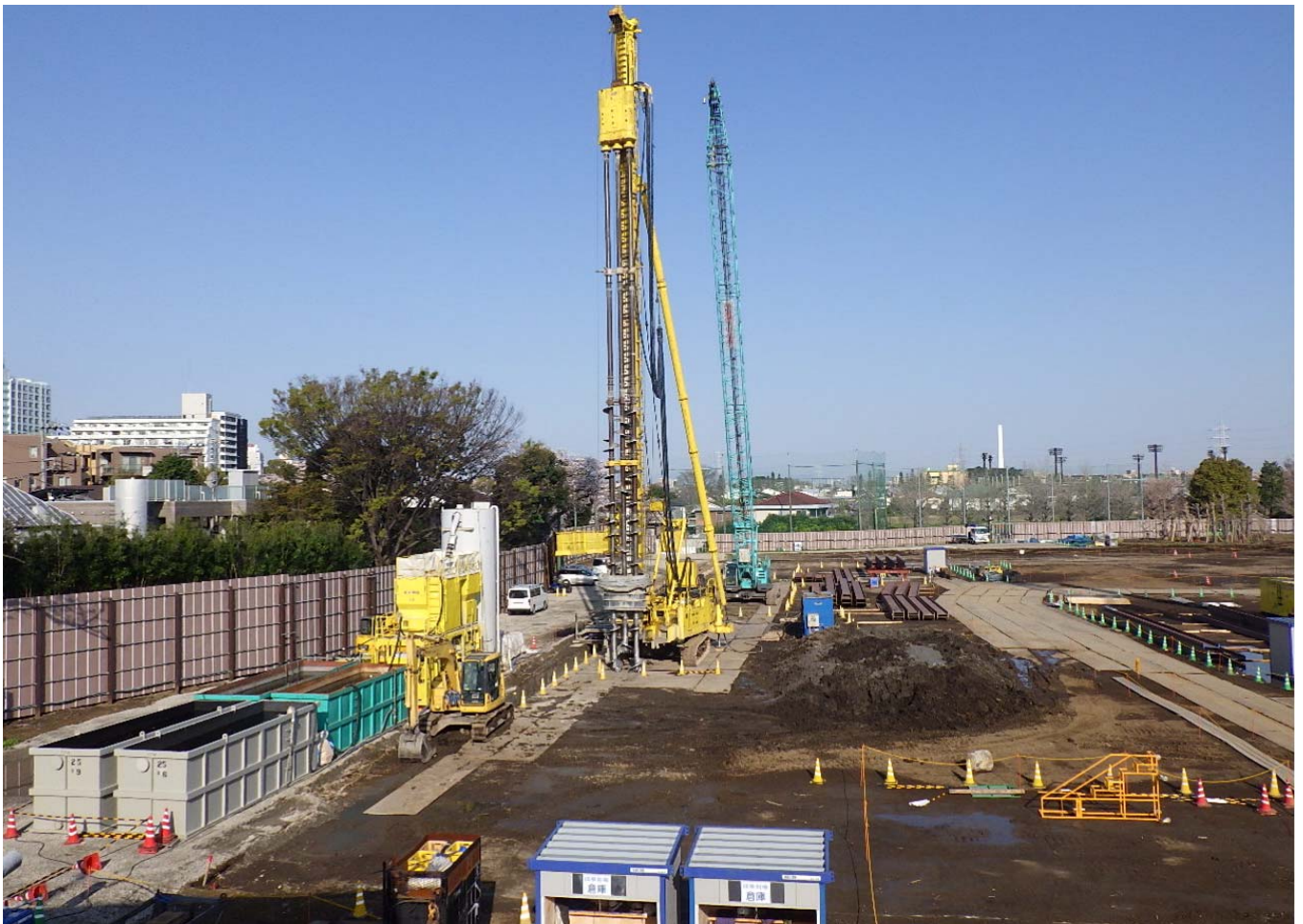
調節池ヤード 西側を望む
